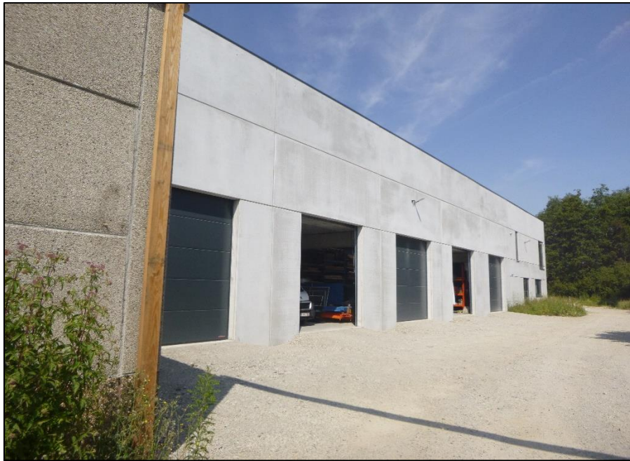
Figuur 7: De nieuwe loods op perceel 401a (ABO nv 2019)
