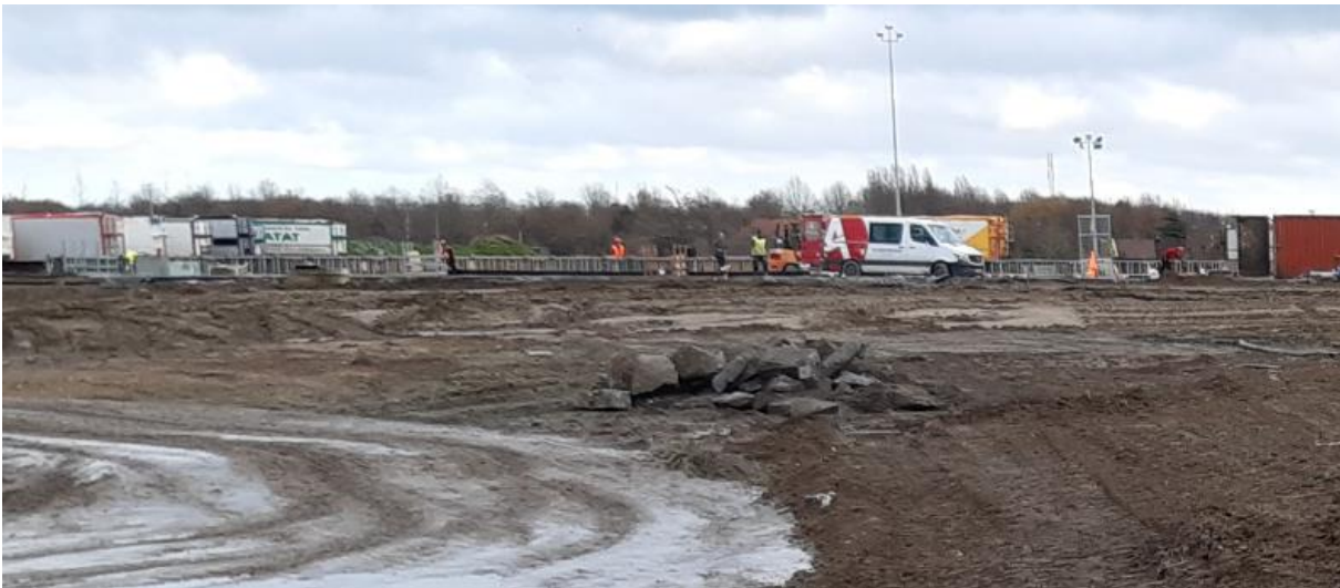
Figuur 3: Aangelegde betonplaat langs de oostelijke grens van het terrein.
