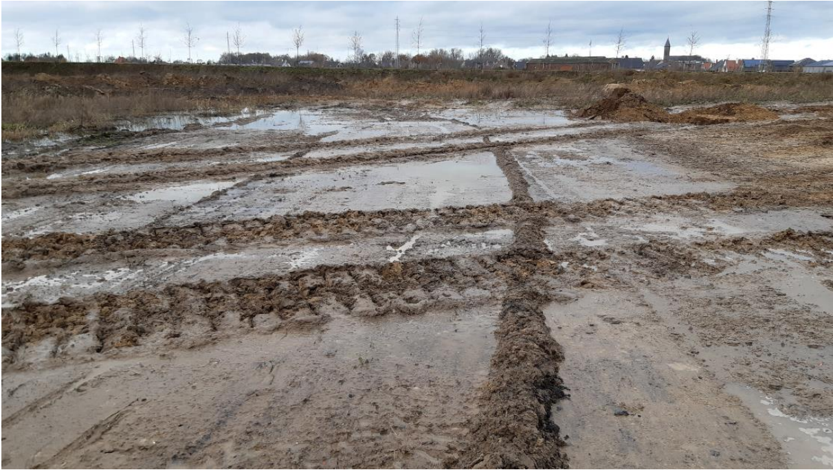
Figuur 9: De grond was op verschillende plekken door recente graafwerkzaamheden waterverzadigd en heel onstabiel.
