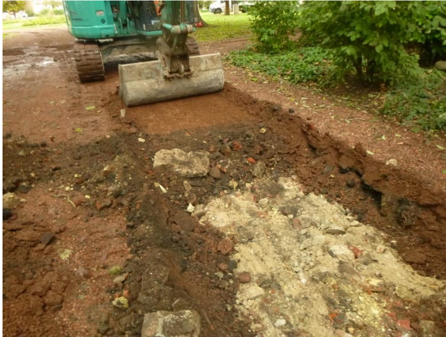
Figuur 19: Aanleg van de lange sleuf ter hoogte van werkput 4.
