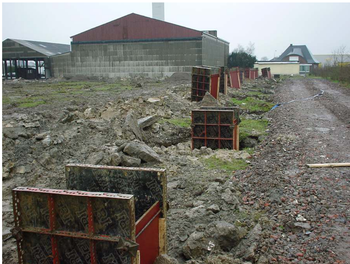
Afbeelding 3.3.1.3: Impressie van het terrein op het ogenblik dat de funderingszool van de aanwezige kolommen bekist werden. Langs de bekistingsgaten kan het puin herkend worden dat uit de ondergrond kwam tijdens de graafwerkzaamheden.
