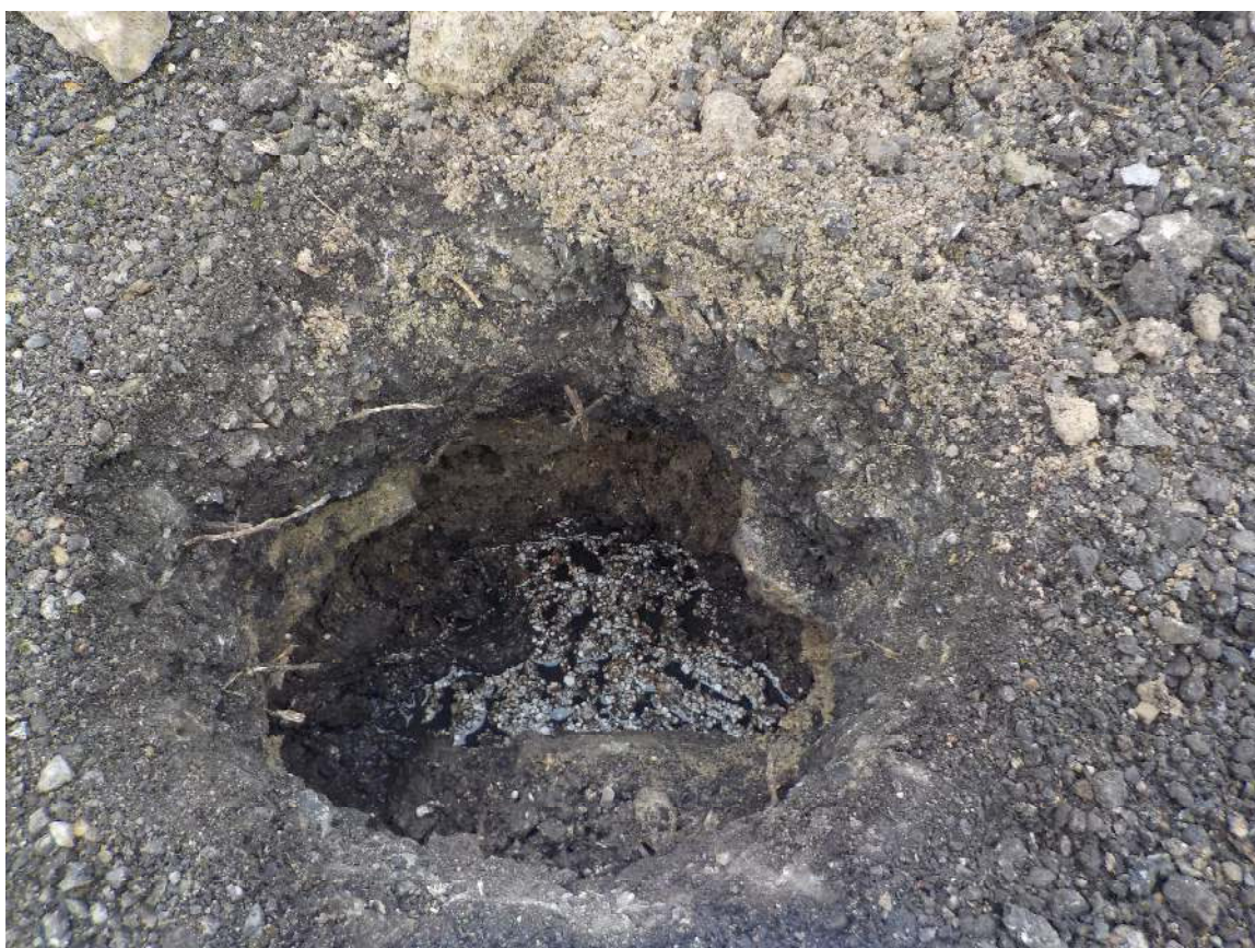
Afbeelding 4.2.1: Hand gegraven put nr. 2. De bovenlaag bestaat uit een KWS-achtige verharding, hieronder is het puinpakket gelegen. Om de elementen in perspectief te zien. De KWS-achtige verharding is circa 25 cm dik, het grondwater zit op 50 cm diepte. Het hand gegraven gat is circa 40 cm in diameter.
