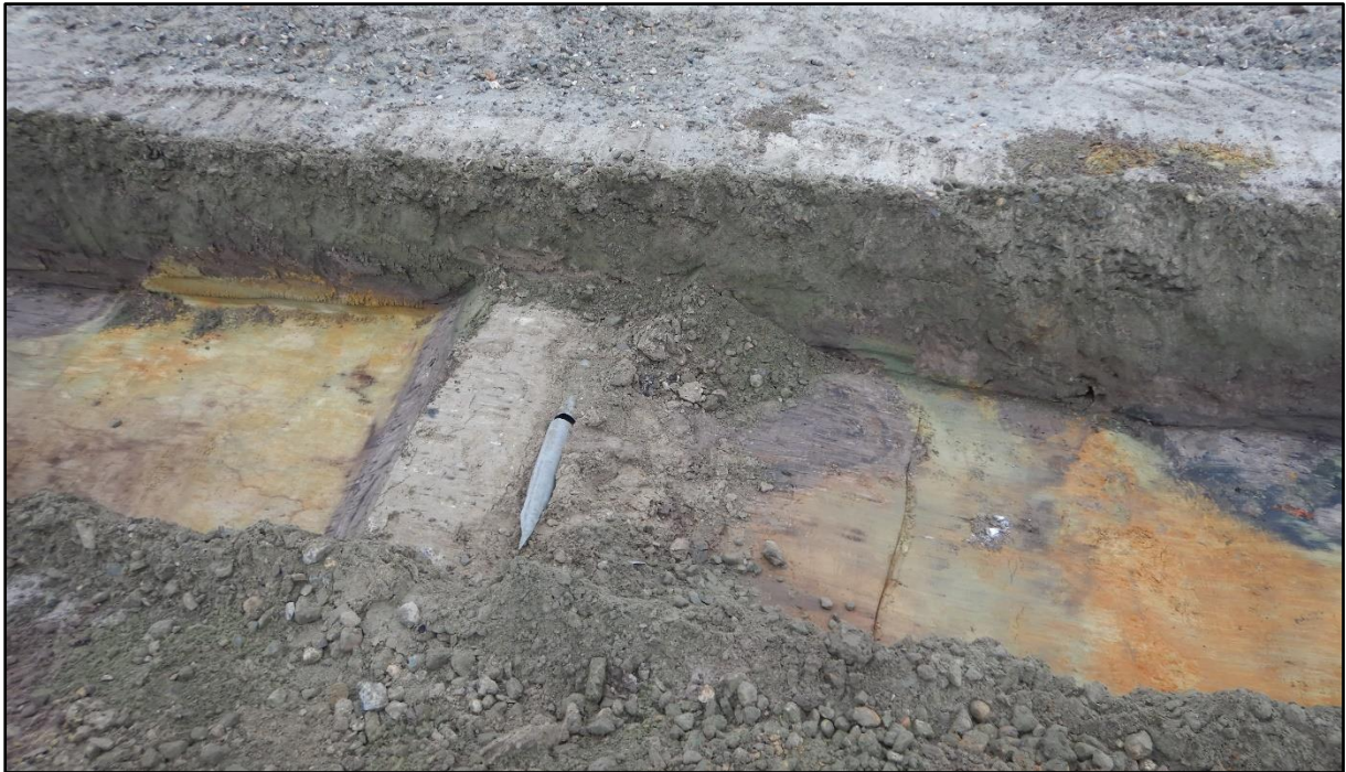
Figuur 22 Nutsleidingen (elektriciteit) centraal in sleuf 3.
