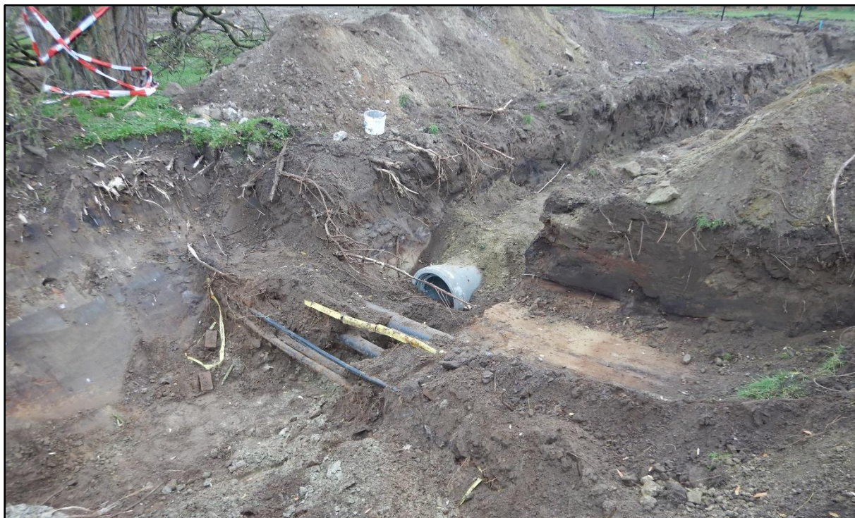
Figuur 2 Aangesloten nutsleidingen (gas en elektriciteit) die vanuit het noorden langsheen de voormalige wegenis loopt.
