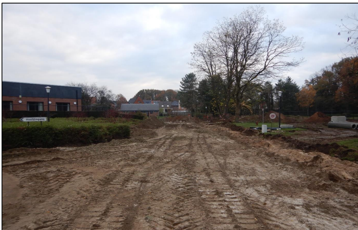
Figuur 3 Zicht op de voormalige wegenis die oppervlakkig uitgebroken werd.
