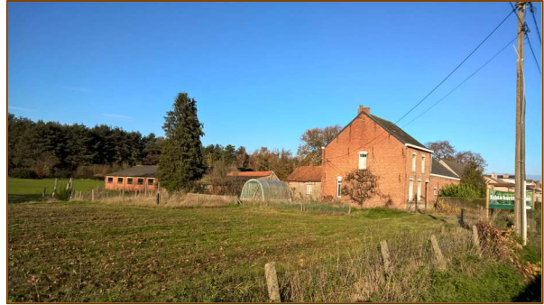
Foto 2: N zone: af te breken woonerf met hoeve, bakstenen bijgebouw en koeienstal, weiland op voorgrond.
