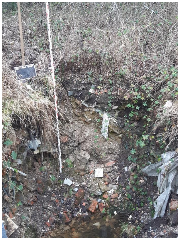
Figuur 10: Controleboring 3 (B3) (© J. Verrijckt bvba)
