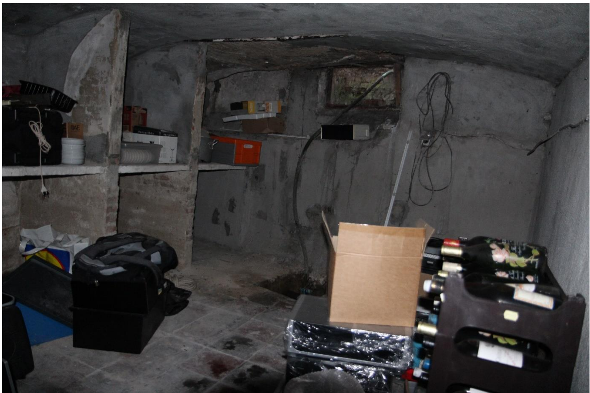
Figuur 34: Deel van de bestaande gewelfde kelderruimte
