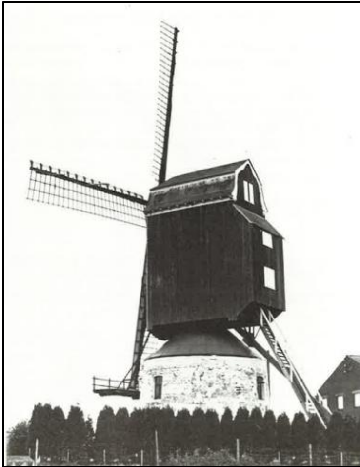
Figuur 25: Een stenen molen waarbij een torenkast (houten gedeelte) op het molenkot (bakstenen onderste gedeelte) staat (bron: DEVLIEGHER L. en DEBONNET A. 1984, p. 315).
