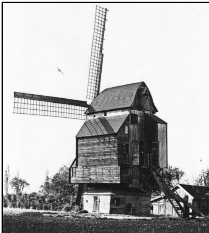
Figuur 23: De Briardemolen te Wormhout, ( gesloten staakmolentype) (bron: DEVLIEGHER L. en DEBONNET A. 1984, p. 56).
