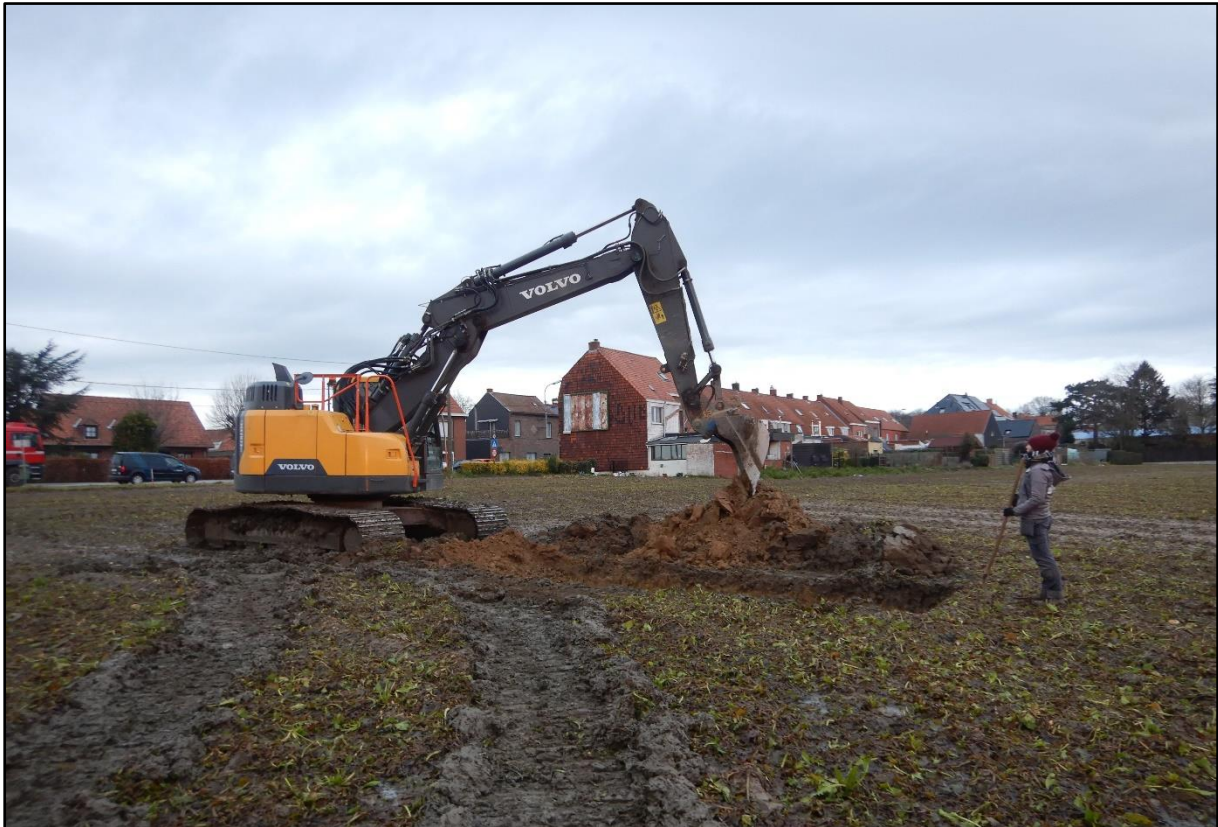
Figuur 4 Aanleg van de proefsleuven.
