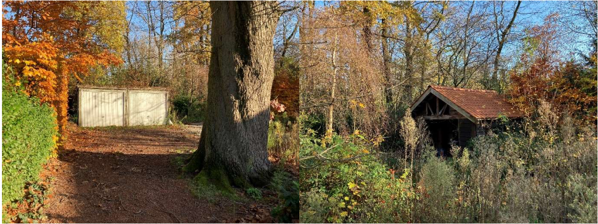
Figuur 3c. Huidige garages en tuinhuis op het perceel 120P die deel uitmaken van het sloopplan.
