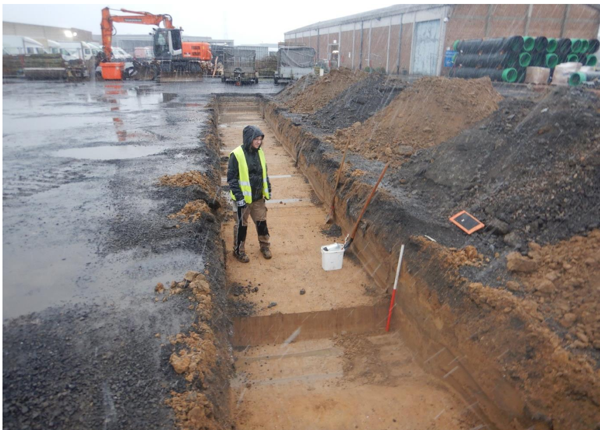
Figuur 13: Overzicht sleuf 2 vanuit het oosten.
