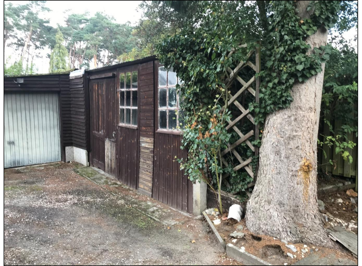
Foto 22: Zicht op garage en bijgebouw in het oosten van het onderzoeksterrein. Foto genomen vanuit het west-zuidwesten.
