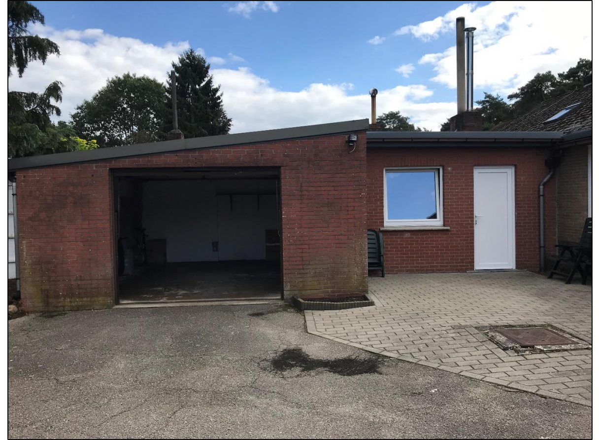
Foto 40: Zicht op woning en garage met aanpalende verhardingen en put in het westen van het onderzoeksterrein. Foto genomen vanuit het west-noordwesten.
