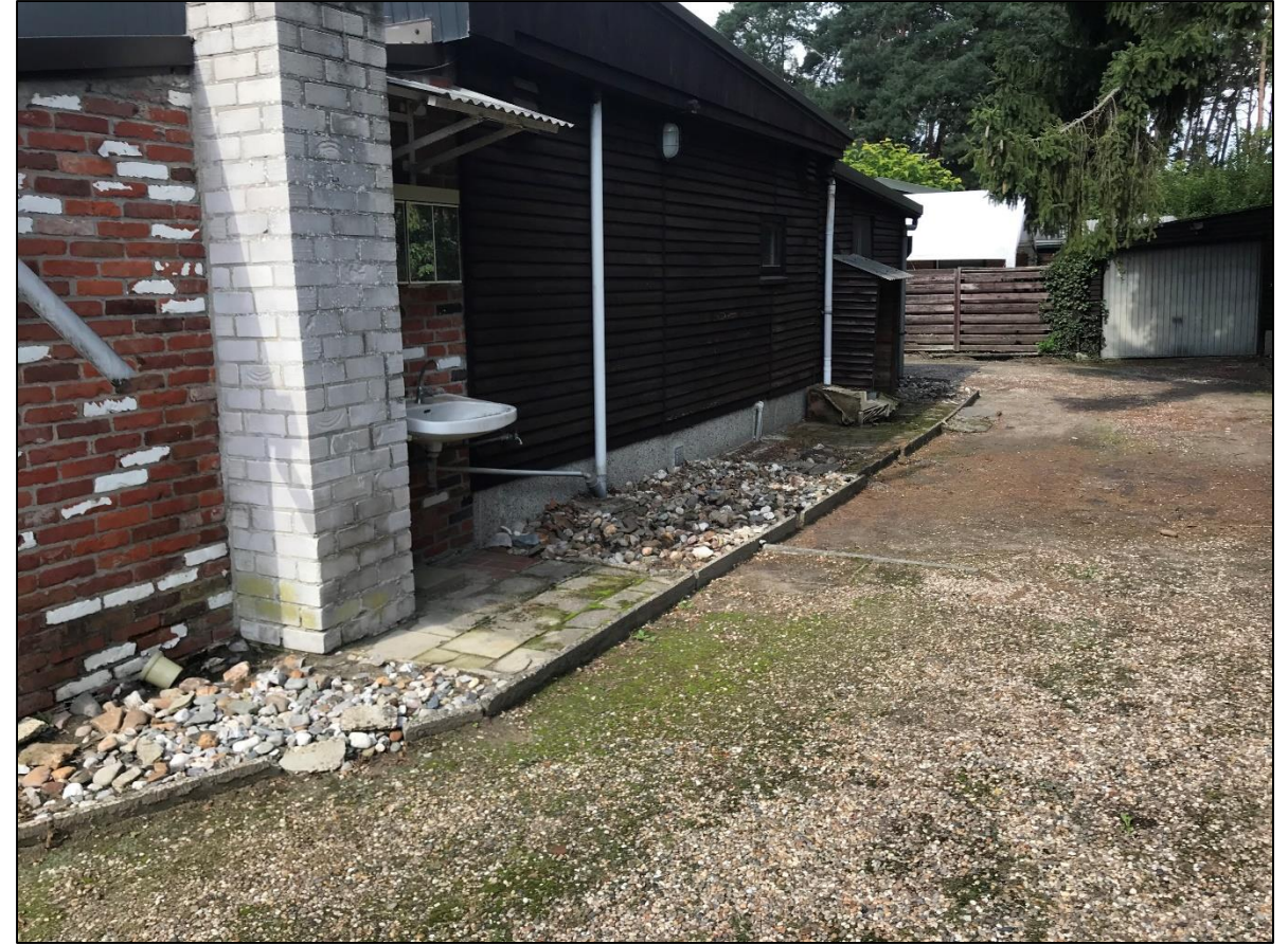
Foto 18: Zicht op gebouw en garage en aanpalende verhardingen in het oosten van het onderzoeksterrein. Foto genomen vanuit het oost-zuidoosten.
