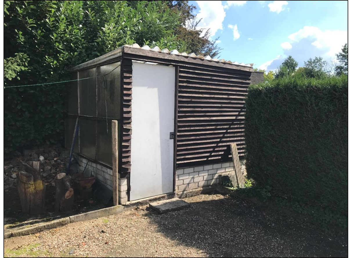
Foto 16: Zicht op bijgebouw in het uiterste oosten van het onderzoeksterrein. Foto genomen vanuit het westen.
