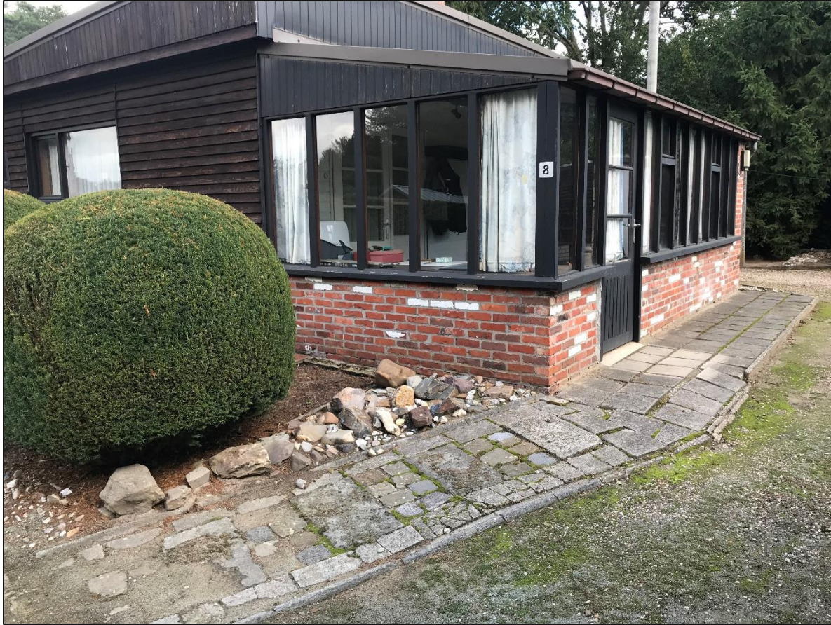
Foto 19: Zicht op gebouw in het oosten van het onderzoeksterrein met omringende verhardingen. Foto genomen vanuit het zuidwesten.
