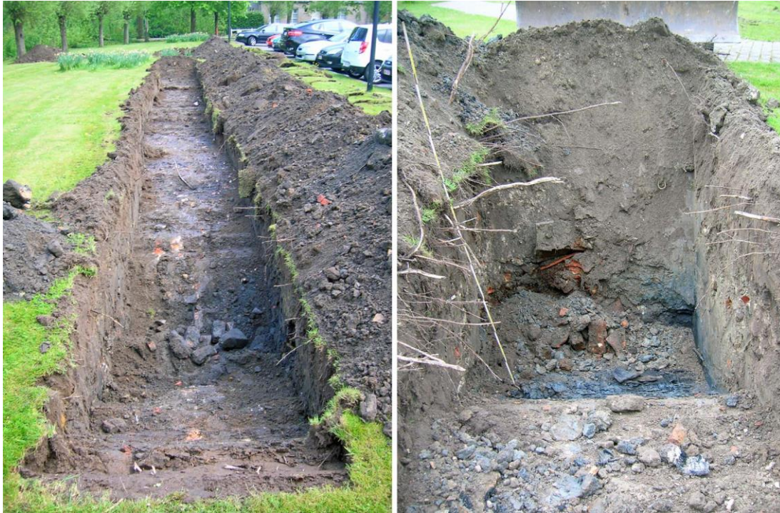
Figuur 29: Sleuf 1 (links) en sleuf 2 (rechts)
