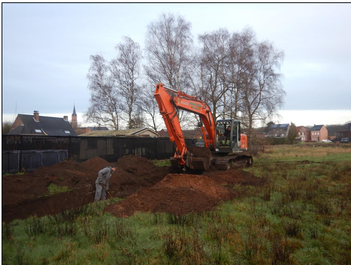
Figuur 6 Sfeerbeeld tijdens de aanleg van de proefsleuven.
