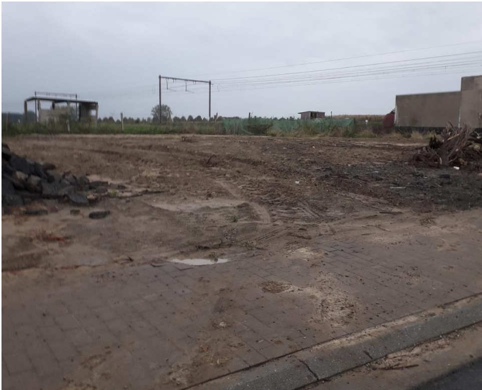
Figuur 7: Foto van de verwijderde omgevingsaanleg ter hoogte van de Kulvestraat 8, gezien vanuit het zuidoosten (Bron: Opdrachtgever).
