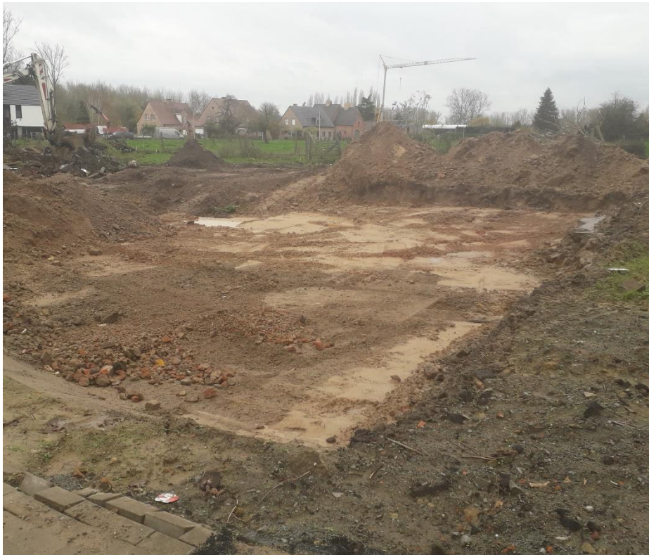
Figuur 5: Foto van de verwijderde bebouwing en omgevingsaanleg ter hoogte van de Kulvestraat 8, gezien vanuit het noord-oosten (Bron: Opdrachtgever).
