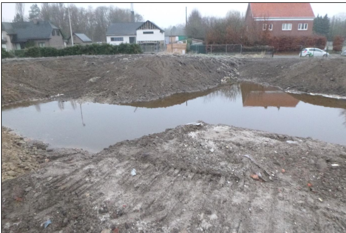
Figuur 18: Uitgraving ten gevolge van het uithalen van de kelder (ABO nv 2020).
