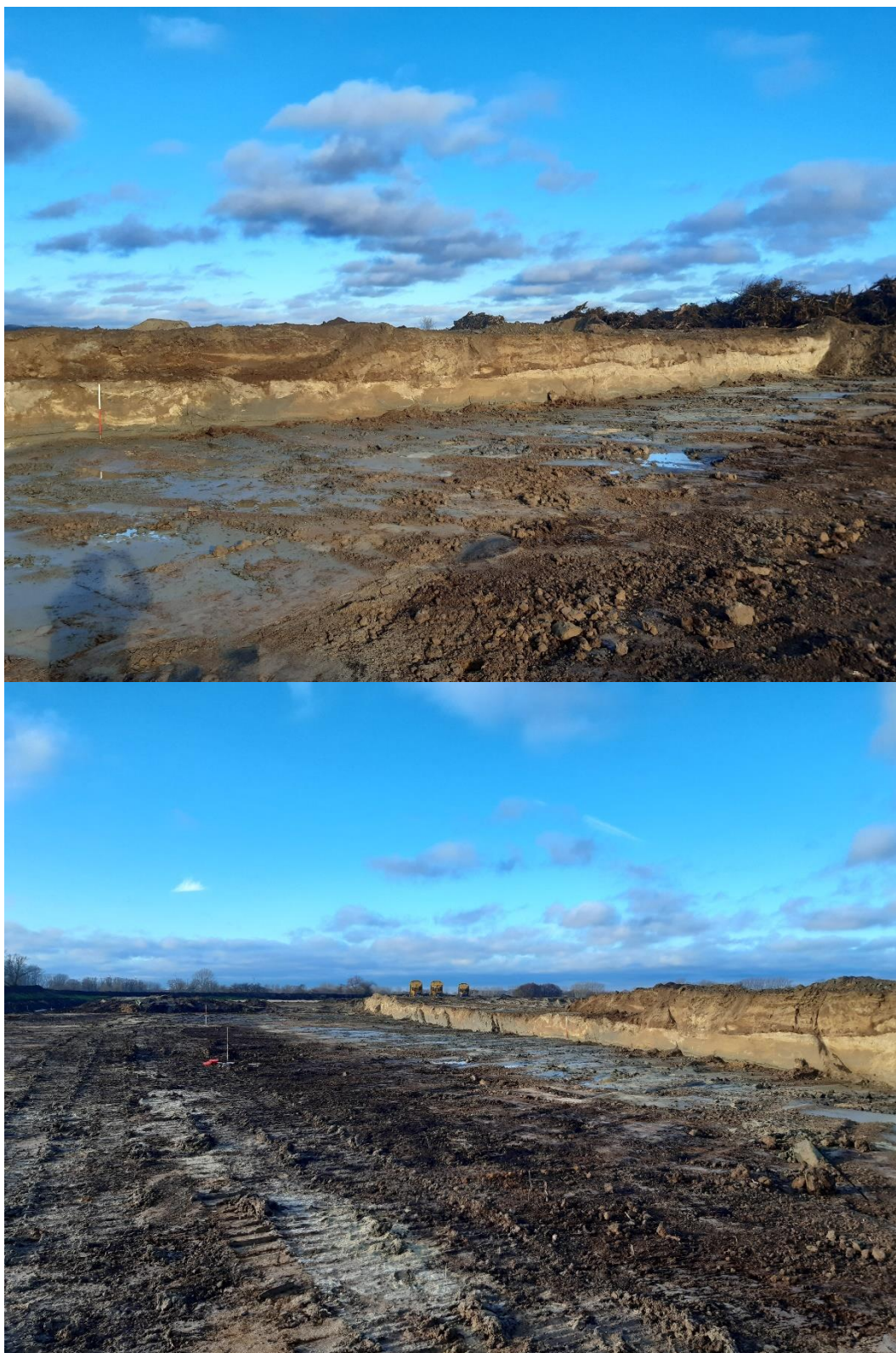
Figuur 10: Zicht op de afgraving en het opgespoten zand (© J. Verrijckt Bvba)
