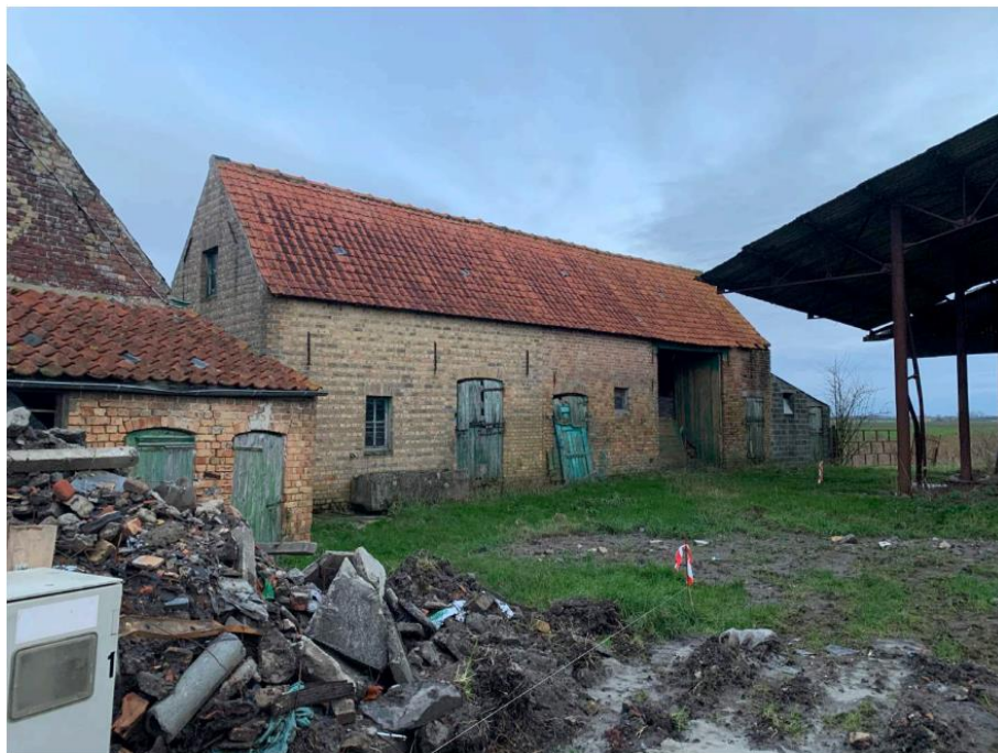
Figuur 3: Zicht op huidige schuur 7
