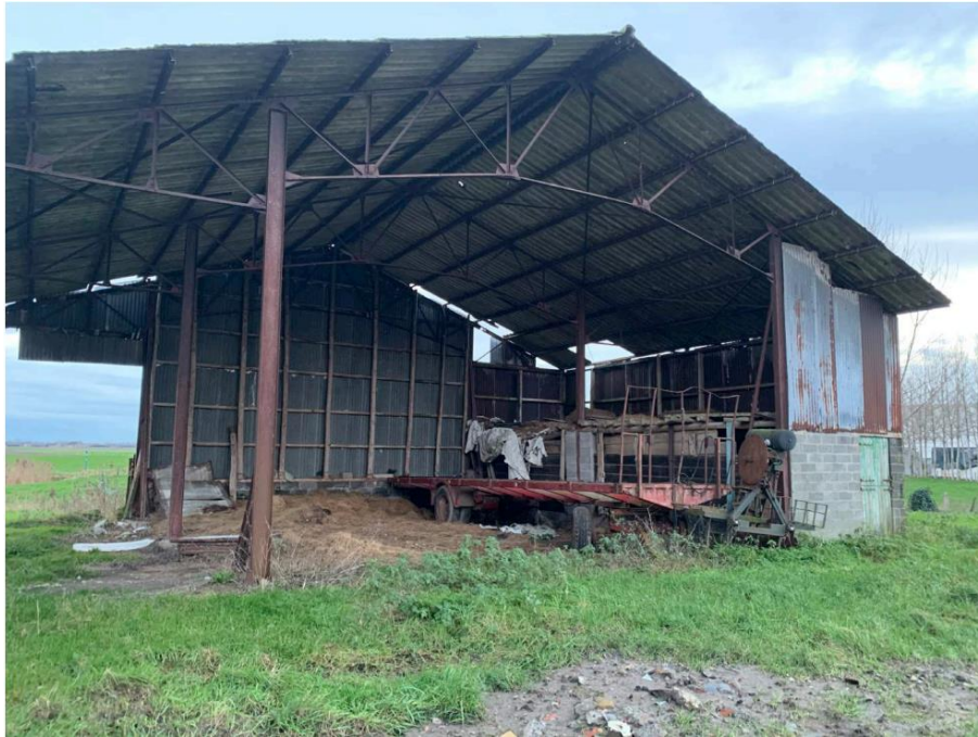
Figuur 4: Zicht op huidige hangar 8
