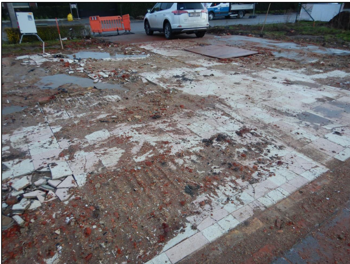
Figuur 4 Zicht op de funderingen, vloeren en kelder (aan de straatkant) van huisnummer 119.
