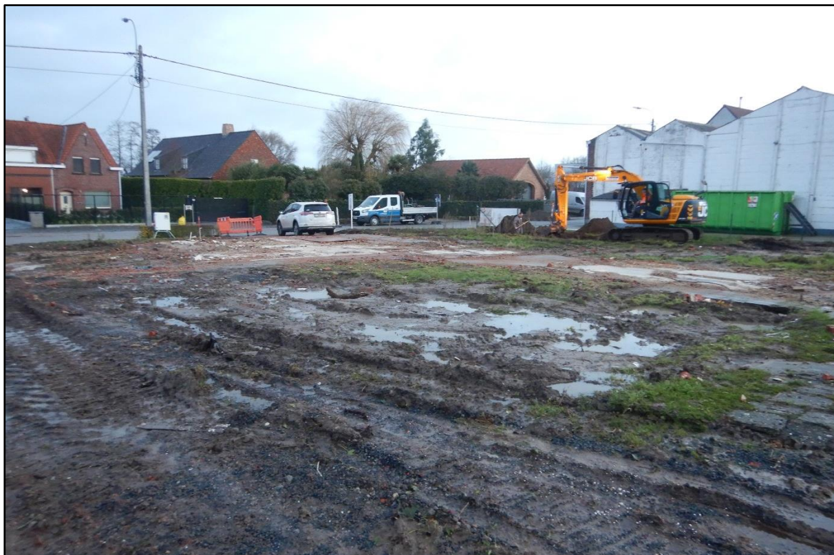
Figuur 11 Sfeerbeeld bij de aanleg van de proefsleuven.
