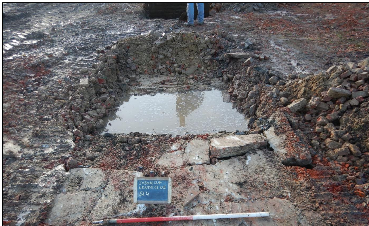
Figuur 22 Zicht op een puinrijke kuil (baksteenpuin en betonbrokken) ter hoogte van de voormalige woning 121.
