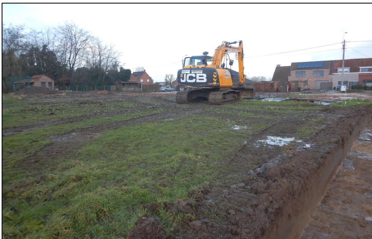
Figuur 12 Sfeerbeeld bij de aanleg van de proefsleuven.
