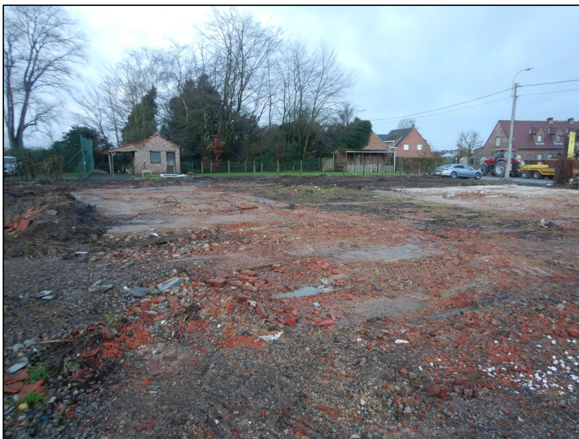
Figuur 3 Zicht op de funderingen van het achterliggende 18 de -eeuwse woonhuis, achter huisnummer 121.
