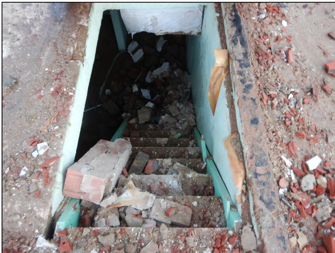
Figuur 5 Toegangstrap tot de grote kelder aan de straatzijde van huisnummer 119.
