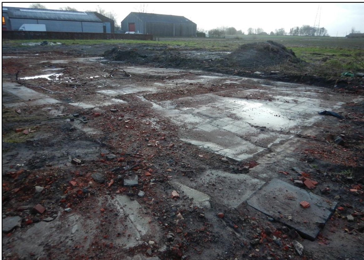
Figuur 2 Zicht op de voormalige westelijke woning (huisnummer 121), deels onderkelderd.
