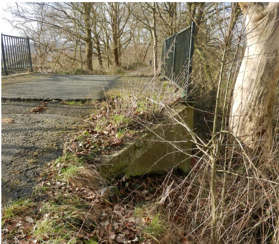
Figuur 1: deel van tracé: brug die over de Ooststraat loopt 8
