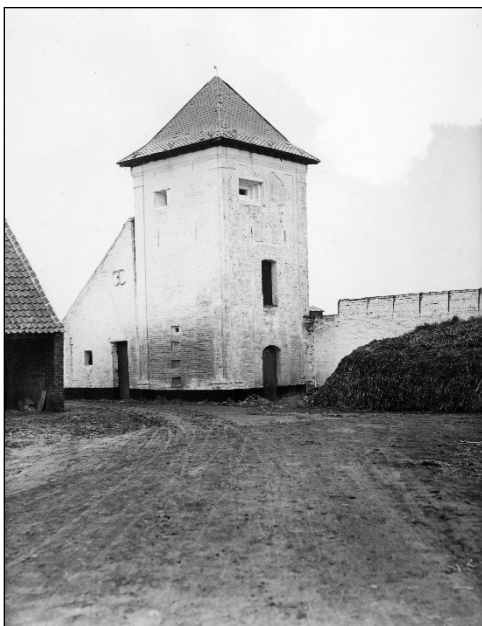
Figuur 34: Duiventoren, situatie 1944 (© KIK-IRPA, Brussels (Belgium), 1944 cliché B059907)
