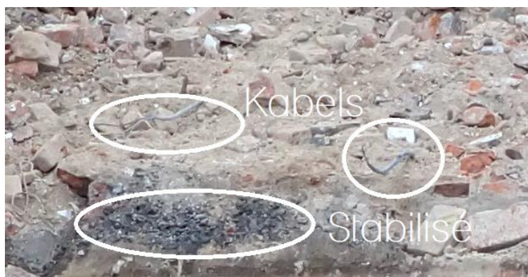
Figuur 48: Detail van inclusies in de recent dichtgesmeten kelder. Er zitten onder meer kabels, stabilisé en bouwpuin in (© J. Verrijckt Bvba)
