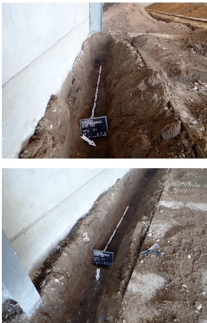
Figuur 63: Overzichtsfoto's van rioleringsleuf 6 (© J. Verrijckt Bvba)
