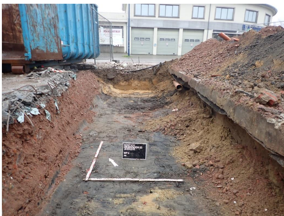
Figuur 48: Detail van inclusies in de recent dichtgesmeten kelder. Er zitten onder meer kabels, stabilisé en bouwpuin in (© J. Verrijckt Bvba)
