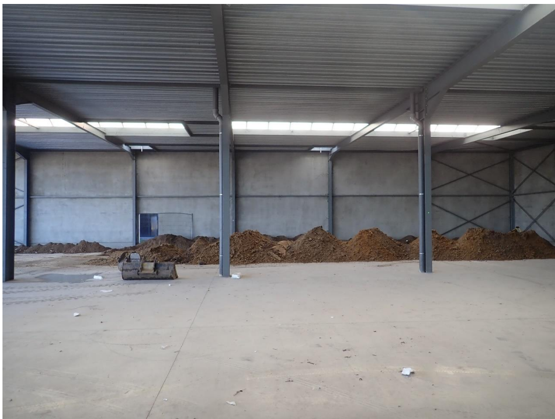
Figuur 19: Foto van het proefsleuvenonderzoek in het zuidwestelijk deel van het terrein, ter hoogte van de toekomstige winkelruimte (© J. Verrijckt Bvba)
