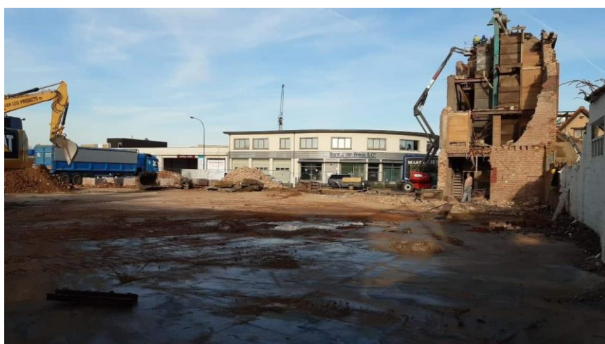
Figuur 26: Foto van de afbraak van het meest noordoostelijke gebouw met zicht uit het zuidoosten (© J. Verrijckt Bvba)
