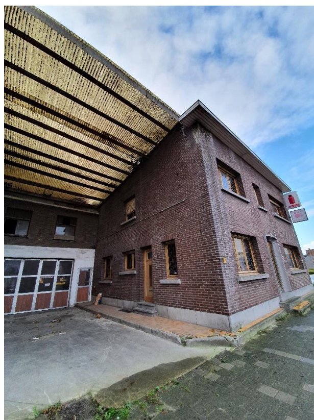
Figuur 23: Zicht op het terrein vanuit het noordwesten voor aanvang van de afbraak (© J. Verrijckt Bvba)
