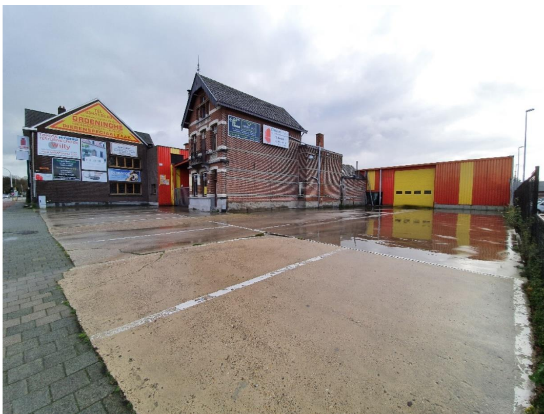
Figuur 21: Zicht op het terrein vanuit het noordwesten voor aanvang van de afbraak (© J. Verrijckt Bvba)
