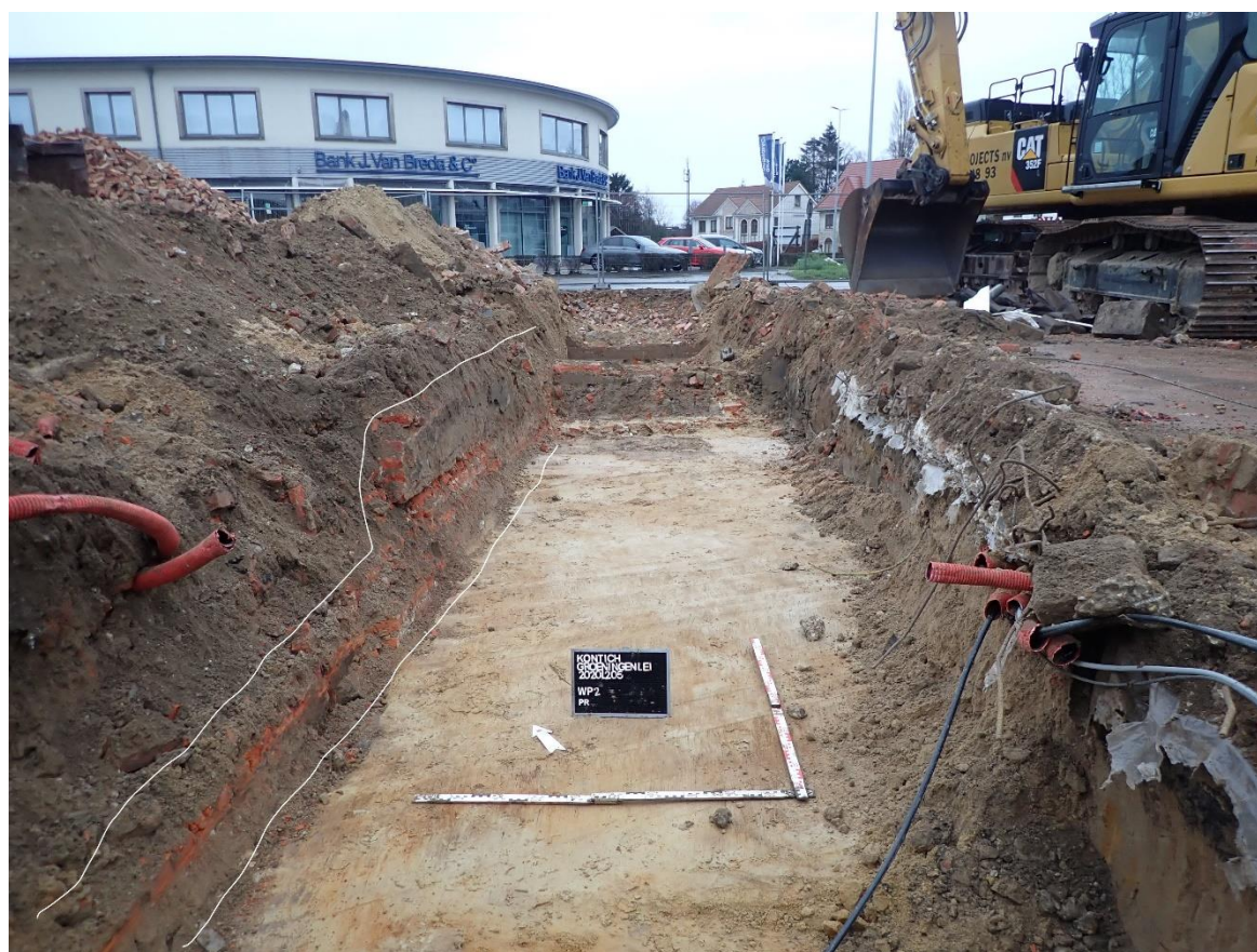
Figuur 45: Foto van de met cement gemetste muur in sleuf twee (© J. Verrijckt Bvba)
