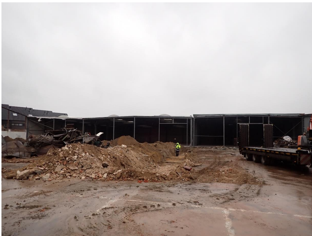
Figuur 4: Foto van het terrein tijdens het proefsleuvenonderzoek met op de achtergrond de gebouwen die grotendeels behouden blijven in het zuiden van de percelen (© J. Verrijckt Bvba)
