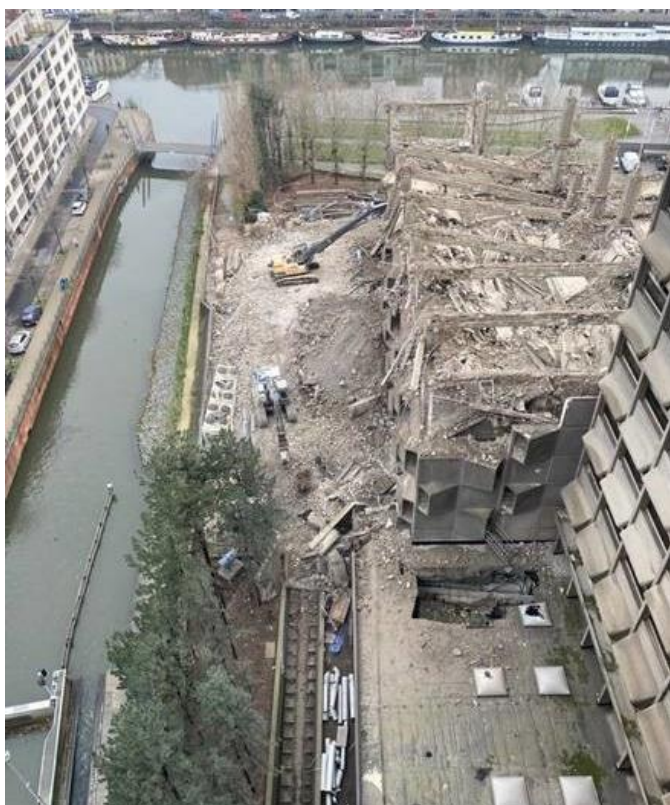
Figuur 5: Momentopname tijdens de afbraak van het technische gebouw. Genomen eind december 2020 (Bron: Opdrachtgever).
