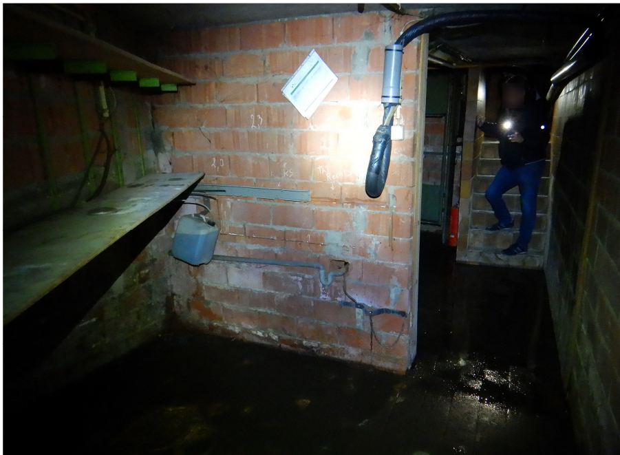
Figuur 6. Zicht op het jeugdhuis en de kelder onder dit pand.
