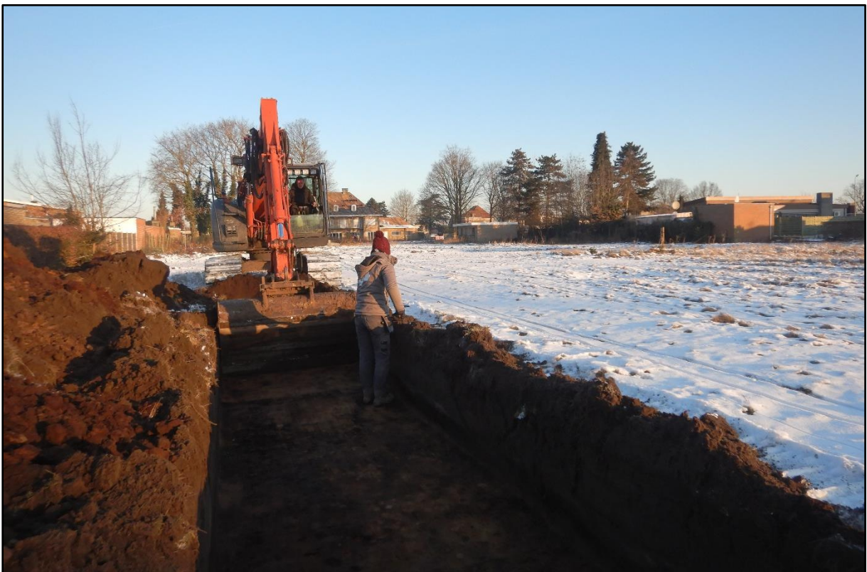
Figuur 5 Sfeerbeeld tijdens de aanleg van de proefsleuven.
