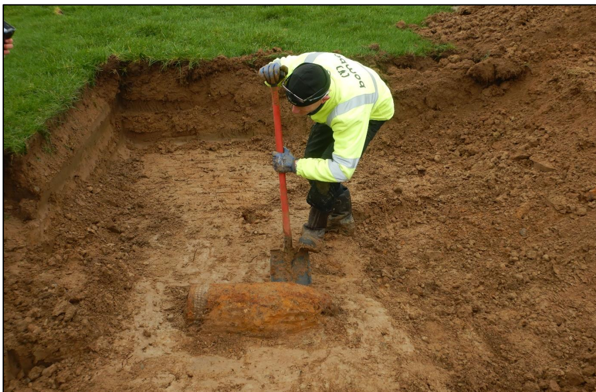
Figuur 8 Veilig stellen van een Britse 9,2inch - ca. 135kg (PV19 – sleuf 8).
