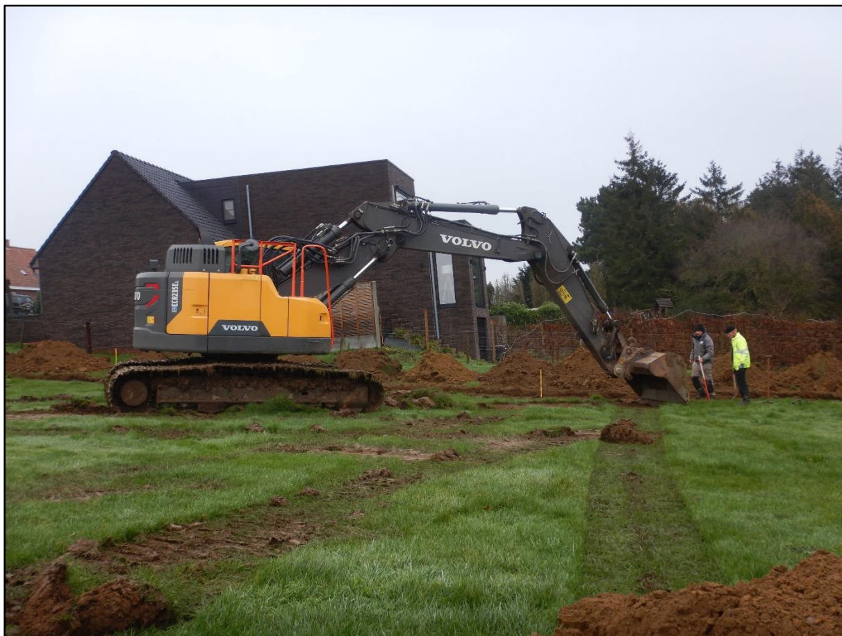
Figuur 6 Sfeerbeeld tijdens de aanleg van de sleuven onder begeleiding van een ontmijner.
