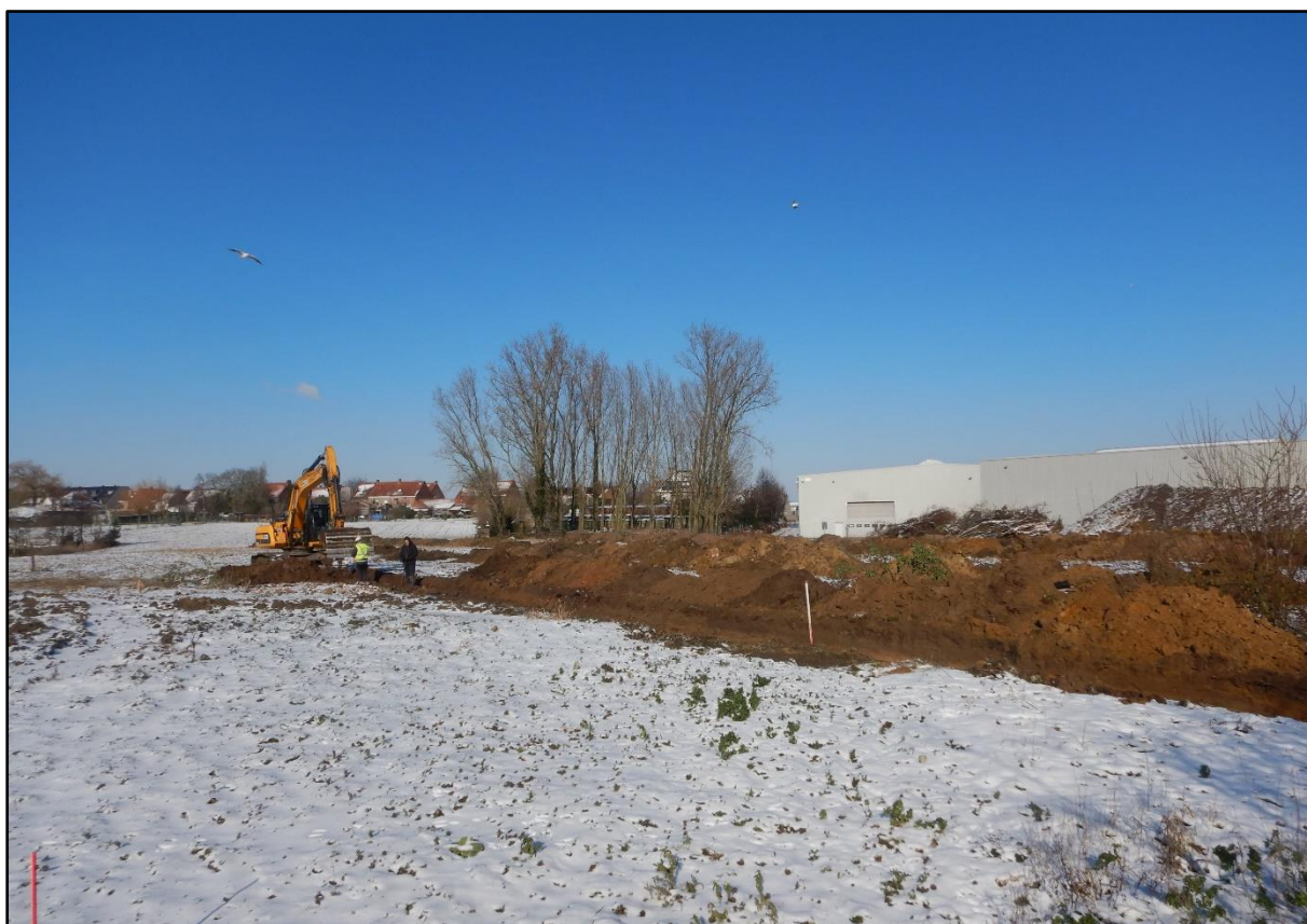
Figuur 6 Sferbeeld tijdens de aanleg van de sleuven onder begeleiding van een ontmijner.
