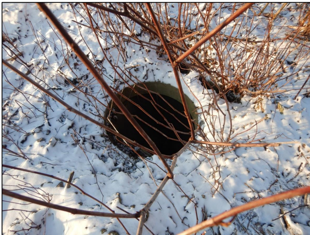
Figuur 10 Zicht op een controleput van de afwatering/overwelfde beek in het noordelijke deel.
