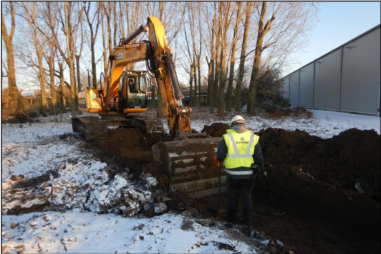
Figuur 7 Begeleiding door ontmijner bij de aanleg van de proefsleuven.
