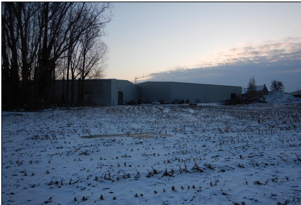
Figuur 5 Zicht op het noordelijke deel van het terrein, met centraal de ingegraven overwelfde beek (niet-zichtbaar op het maaiveldniveau).
