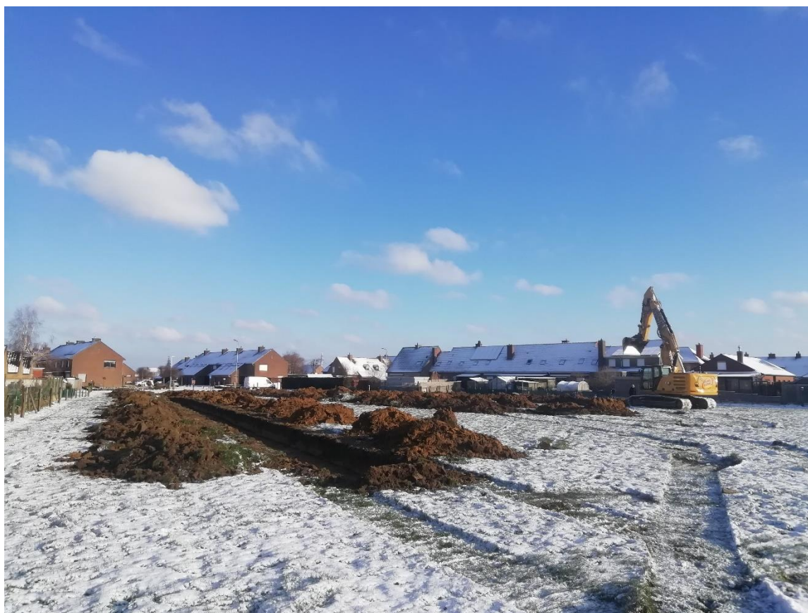
Figuur 15: Overzicht sleuven vanuit zuidwestelijke hoek.
