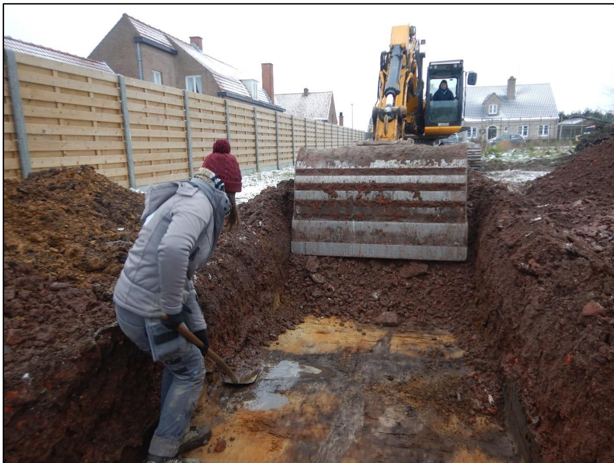
Figuur 6 Sfeerbeeld bij de aanleg van de proefsleuven.
