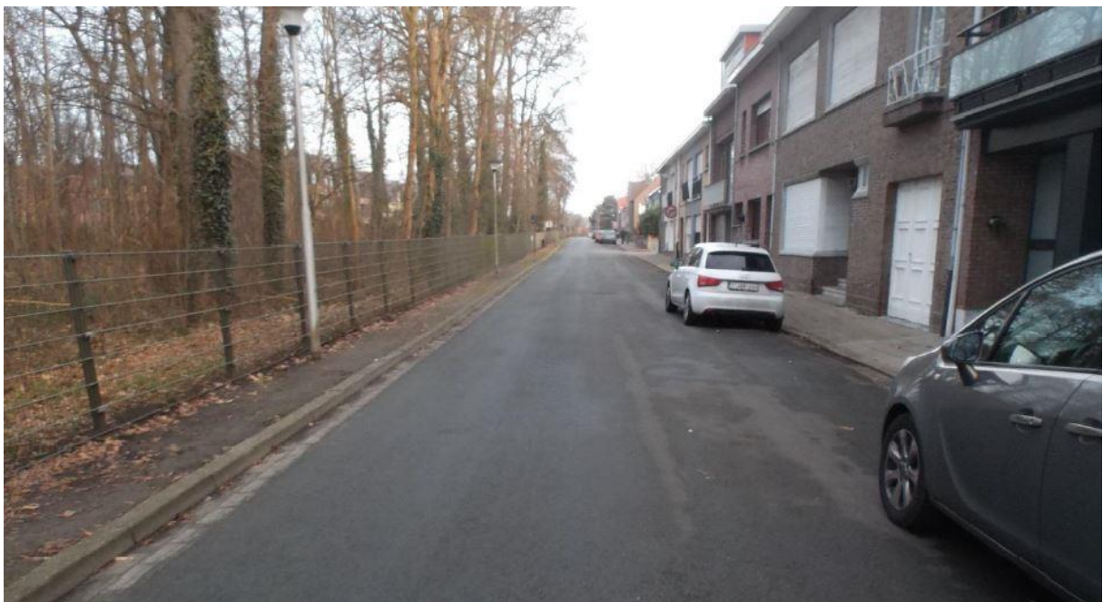
Figuur 5: Foto van de bestaande toestand van de Wirixdreef (Initiatiefnemer 2021).
