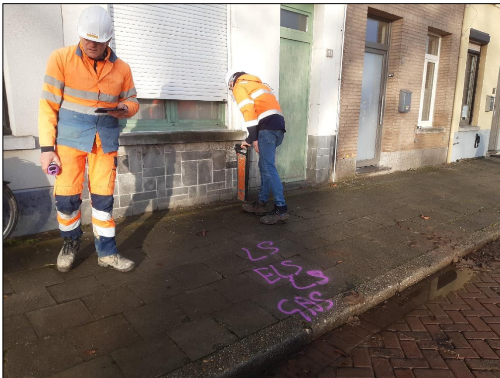
Figuur 4: De locatie van leidingen en kabels werd door de aannemer gedetecteerd en aangeduid (Hier ter hoogte van WP 2)
