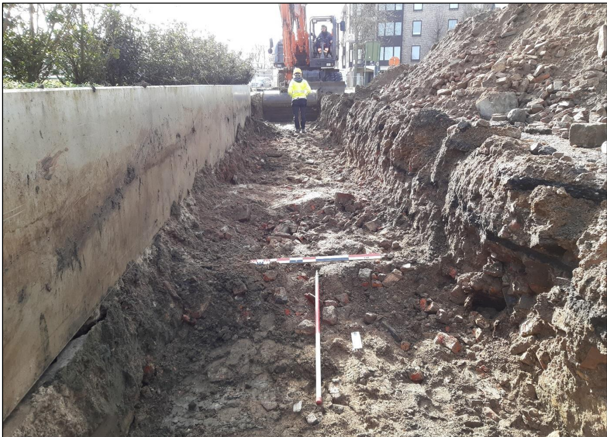
Figuur 30: Grootschalige verstoring in werkput 4
