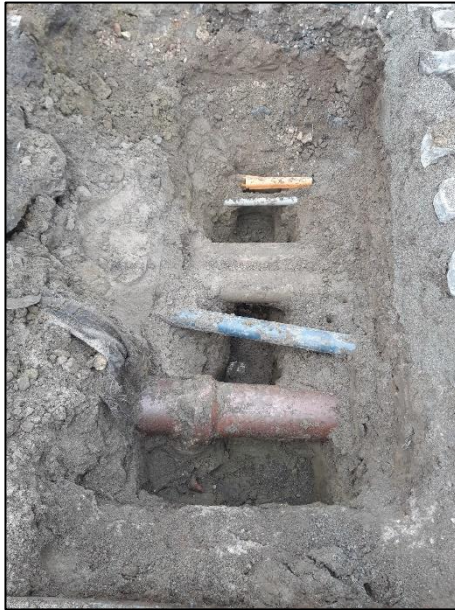
Figuur 5: Aanwezige leidingen ter hoogte van werkput 1, op de hoek van de Hazenstraat
