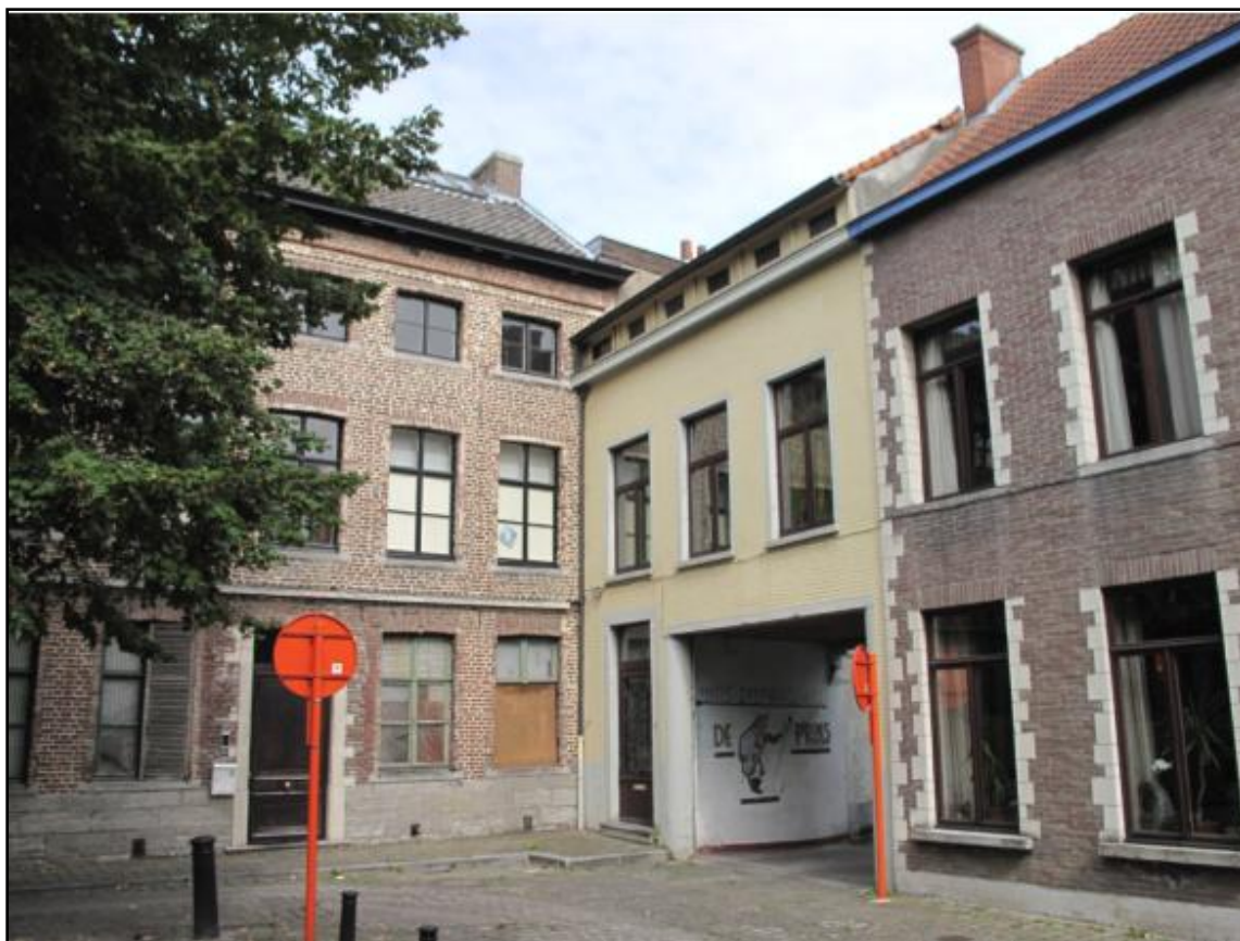
Figuur 5 Zicht op de woning gelegen aan het Prinsenhofplein 7 (bron: a154 Architecten).
