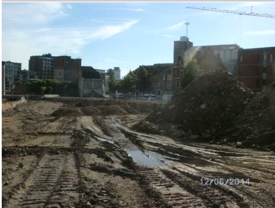
Fig. 1.10: Zicht op het terrein na het dempen van de uitgravingen.
