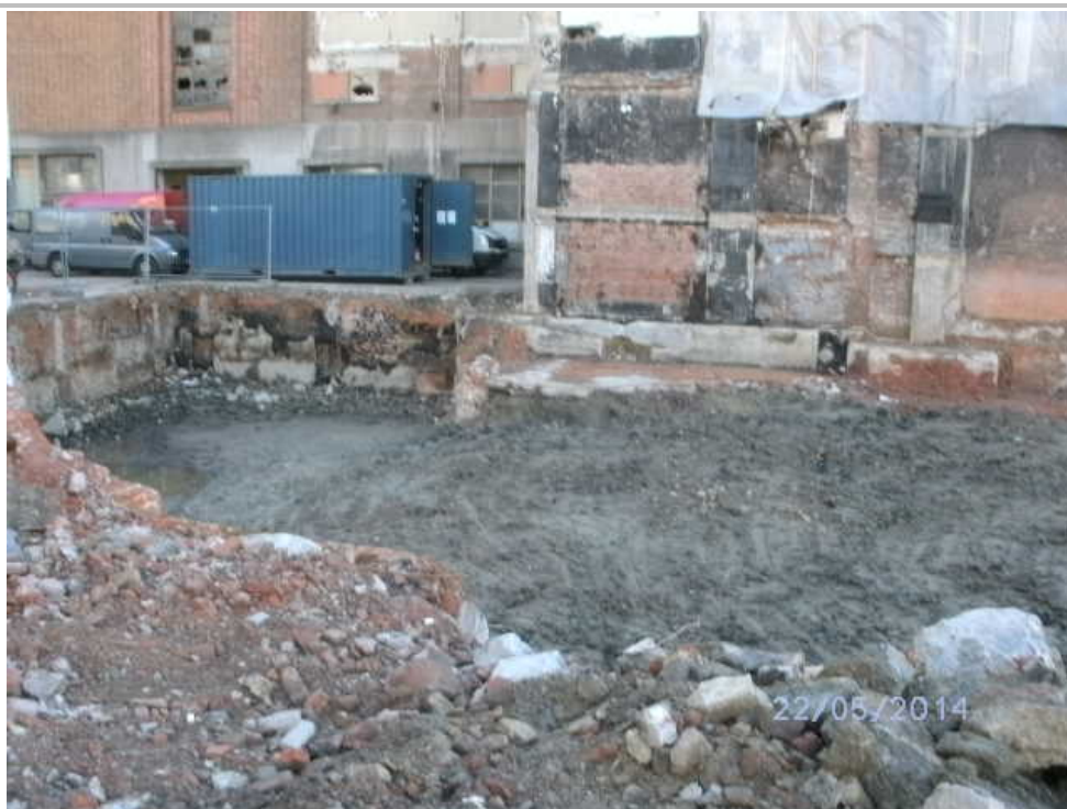
Fig. 1.8: Zicht op de uitgegraven kelder onder gebouw S8.
