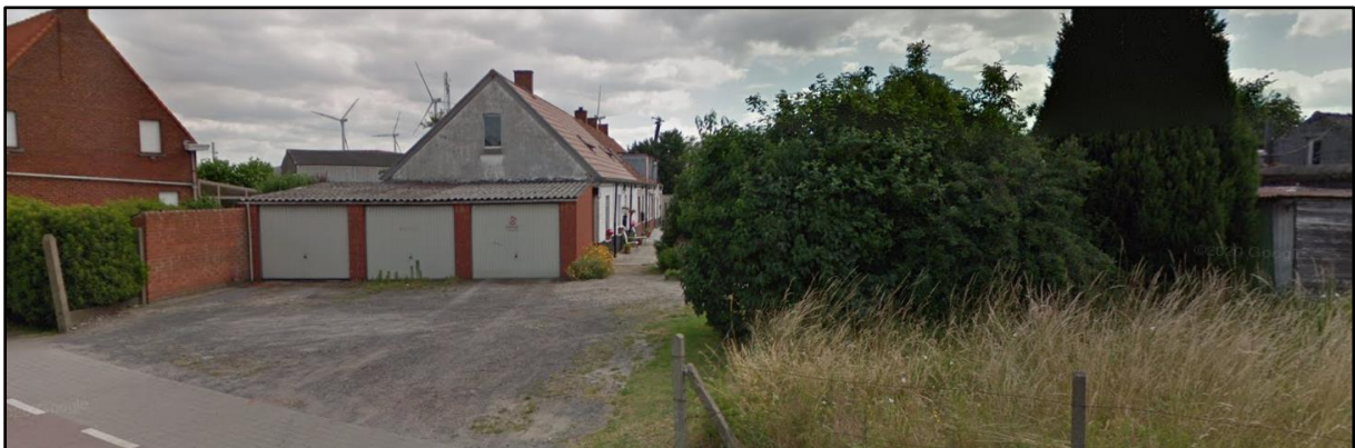
Figuur 4 Beeld op het uiterst noordelijk deel van het plangebied gezien vanuit het westen, met zicht op de garageboxen en grindverharding (bron: https://www.google.com/maps/ ).
