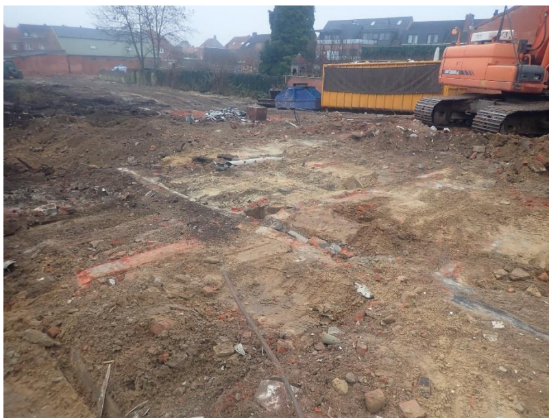
Figuur 25: Zicht op de aanwezige funderingsbalken (© J. Verrijckt Bvba).
