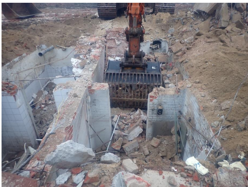
Figuur 22: Zicht op de slopingswerken (© J. Verrijckt Bvba).
