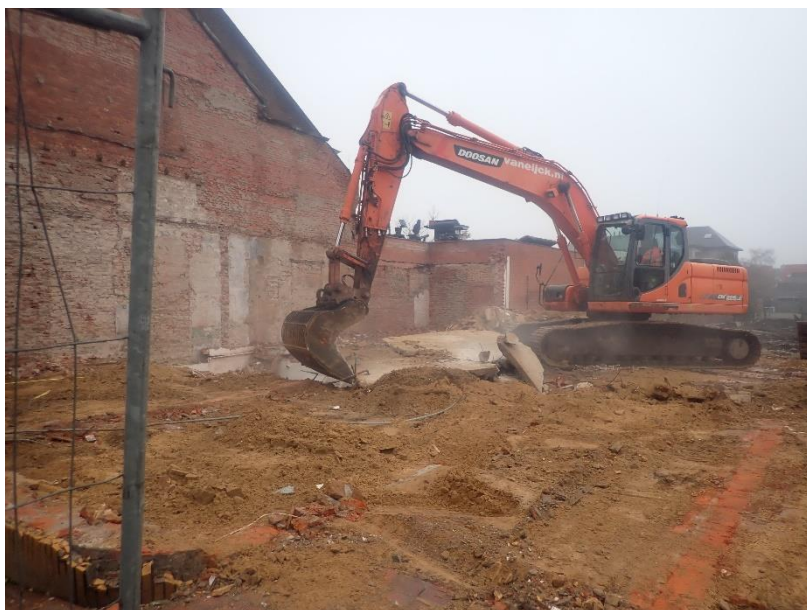
Figuur 23: Zicht op de slopingswerken (© J. Verrijckt Bvba).
