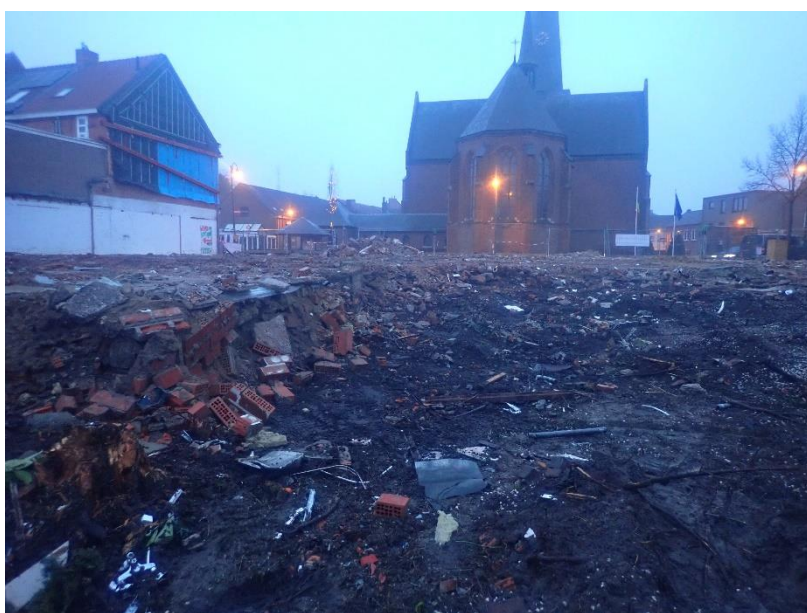
Figuur 20: Zicht op het terrein vanuit het plangebied naar de kerk (© J. Verrijckt Bvba).
