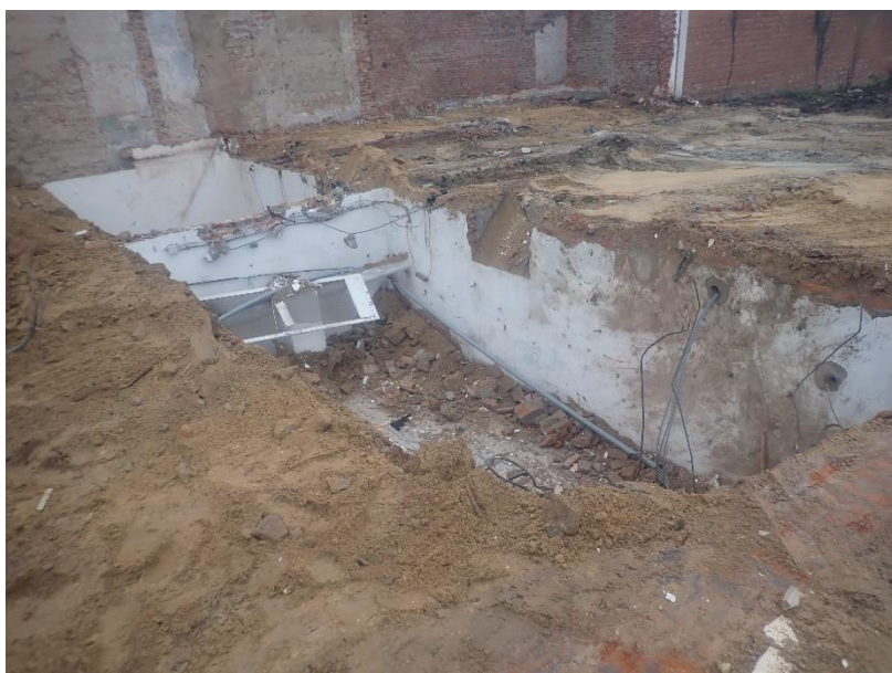
Figuur 24: Zicht op een kelder (© J. Verrijckt Bvba).
