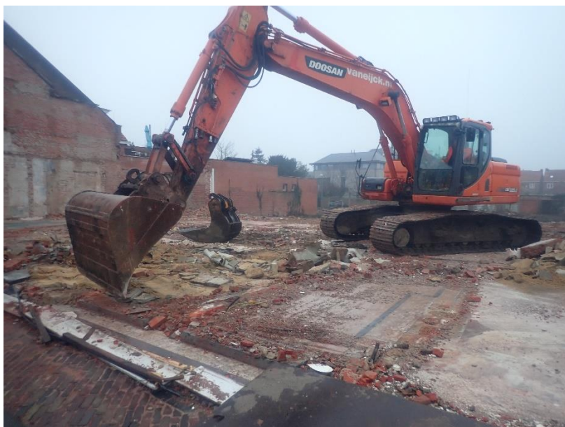
Figuur 21: Zicht op de slopingswerken (© J. Verrijckt Bvba).
