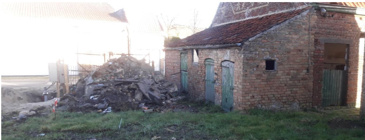
Figuur 2 : Zicht op het plangebied ter hoogte van boring 2A, gezien vanuit het zuiden.
