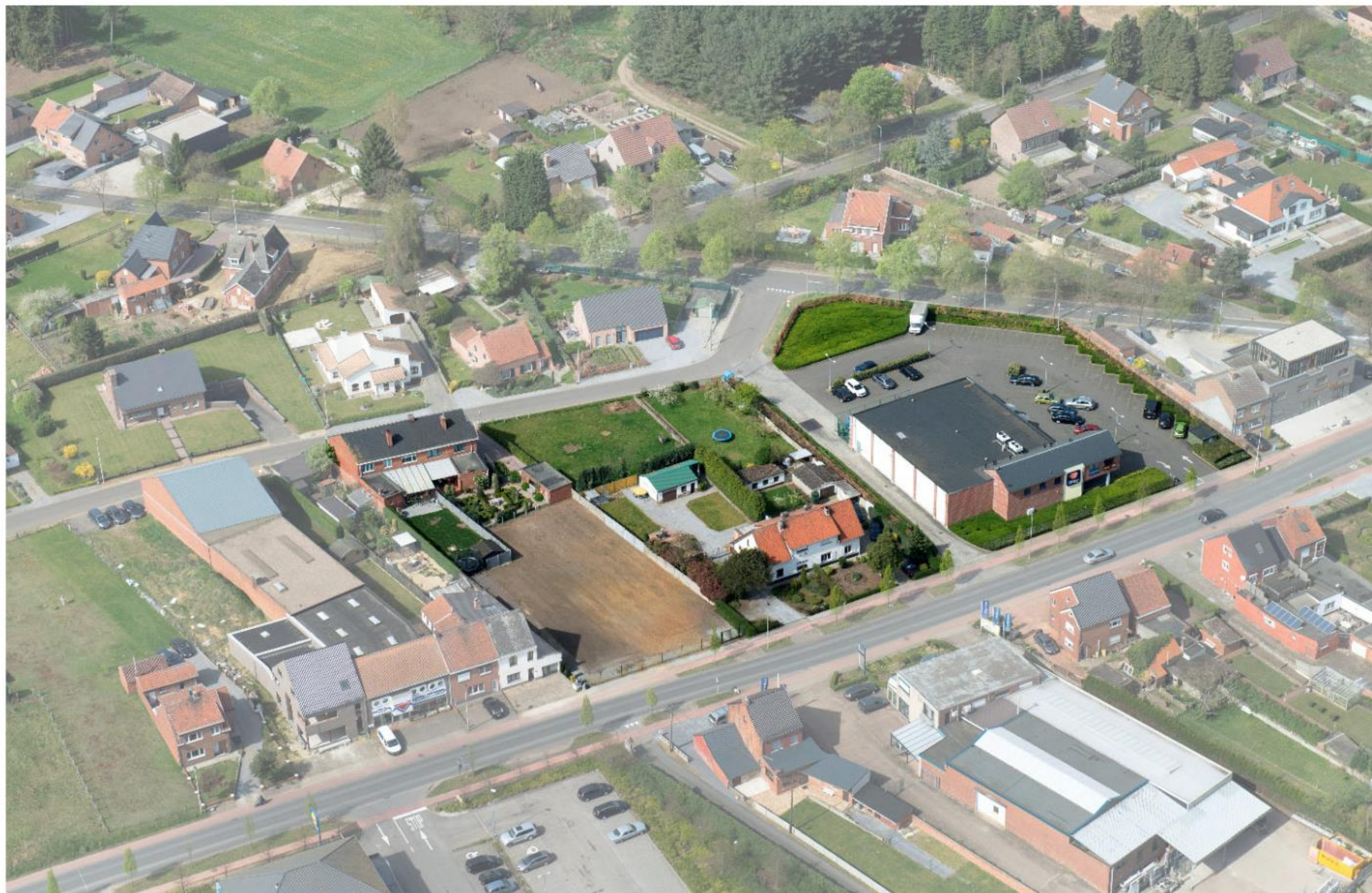
Figuur 4: Luchtfoto bestaande toestand
