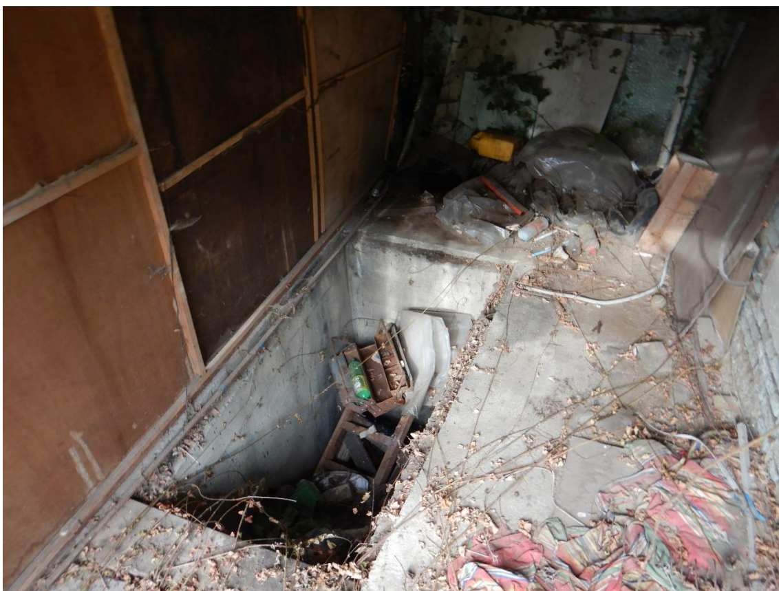
Figuur 11: Werkfoto kelder bijgebouw
