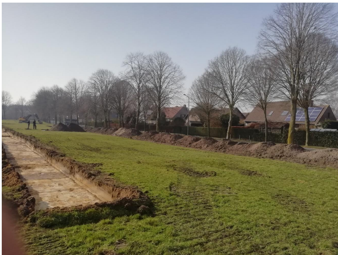
Figuur 10: Overzicht sleuven vanuit zuidoostelijke hoek.
