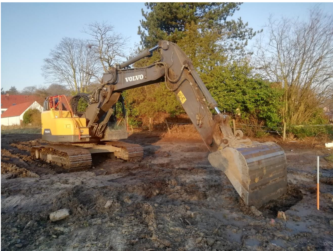
Figuur 6: Begin van sleuf 1, in het noordoosten van het projectgebied.
