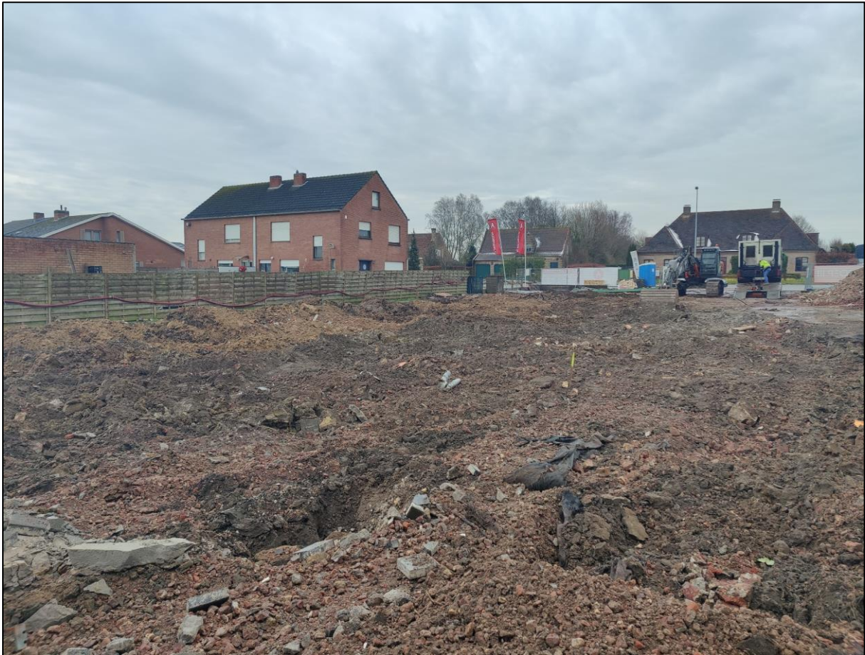
Figuur 26: Terreintoestand bij het uitvoeren van het proefsleuvenonderzoek na de bovengrondse sloop (ABO nv 2021)
