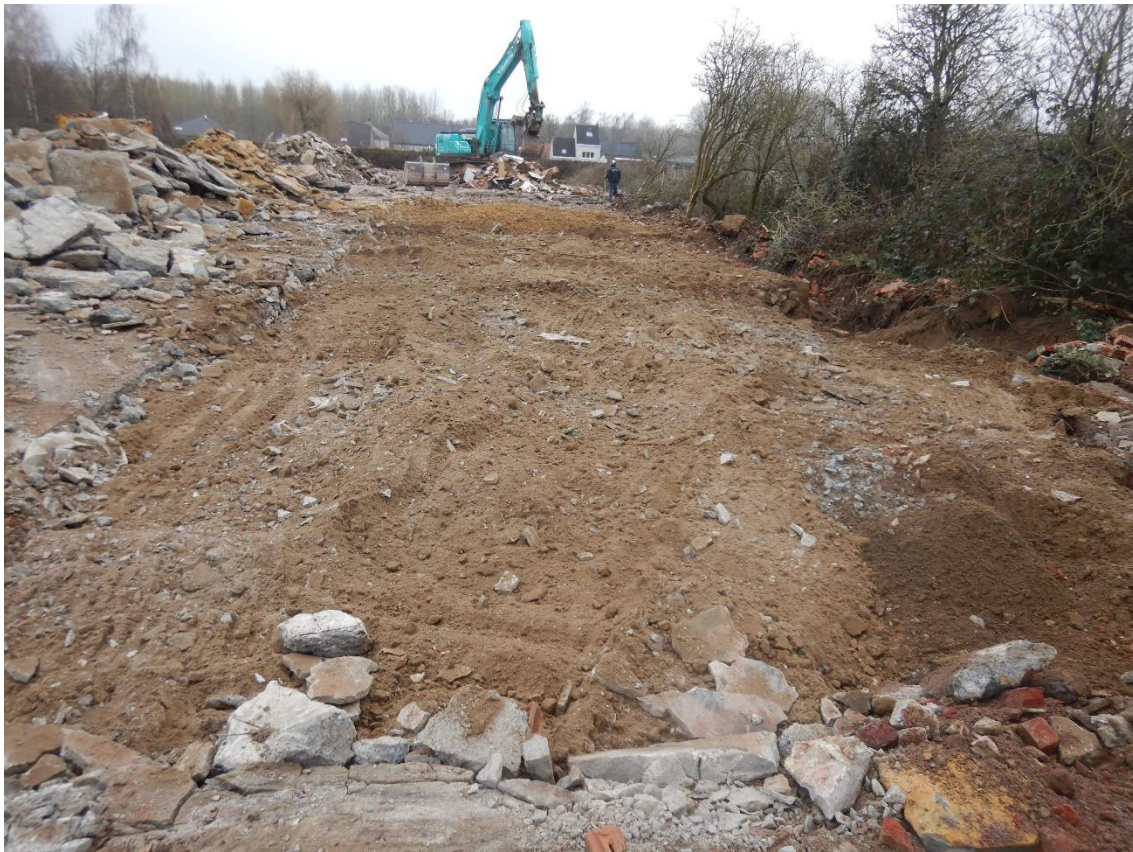
Figuur 8: Werkfoto uitgebroken betonplaat
