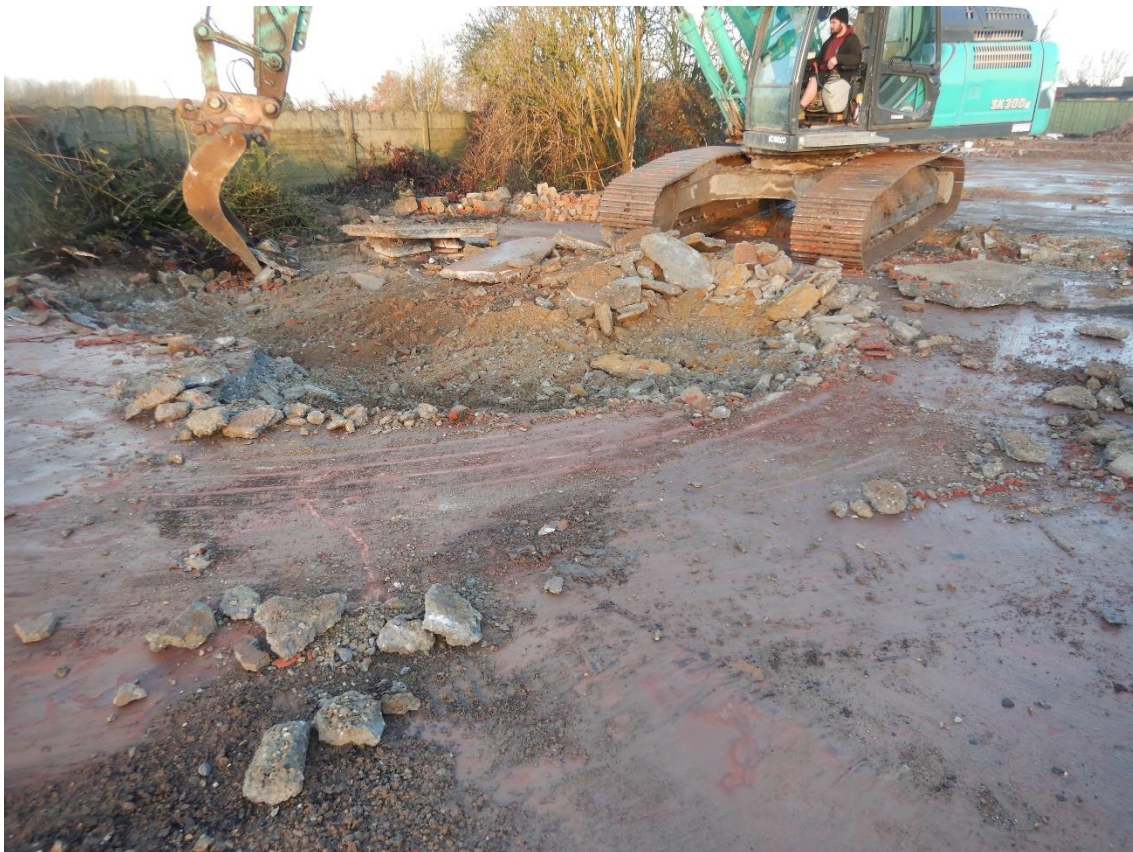
Figuur 7: Werkfoto uitbreken betonplaat
