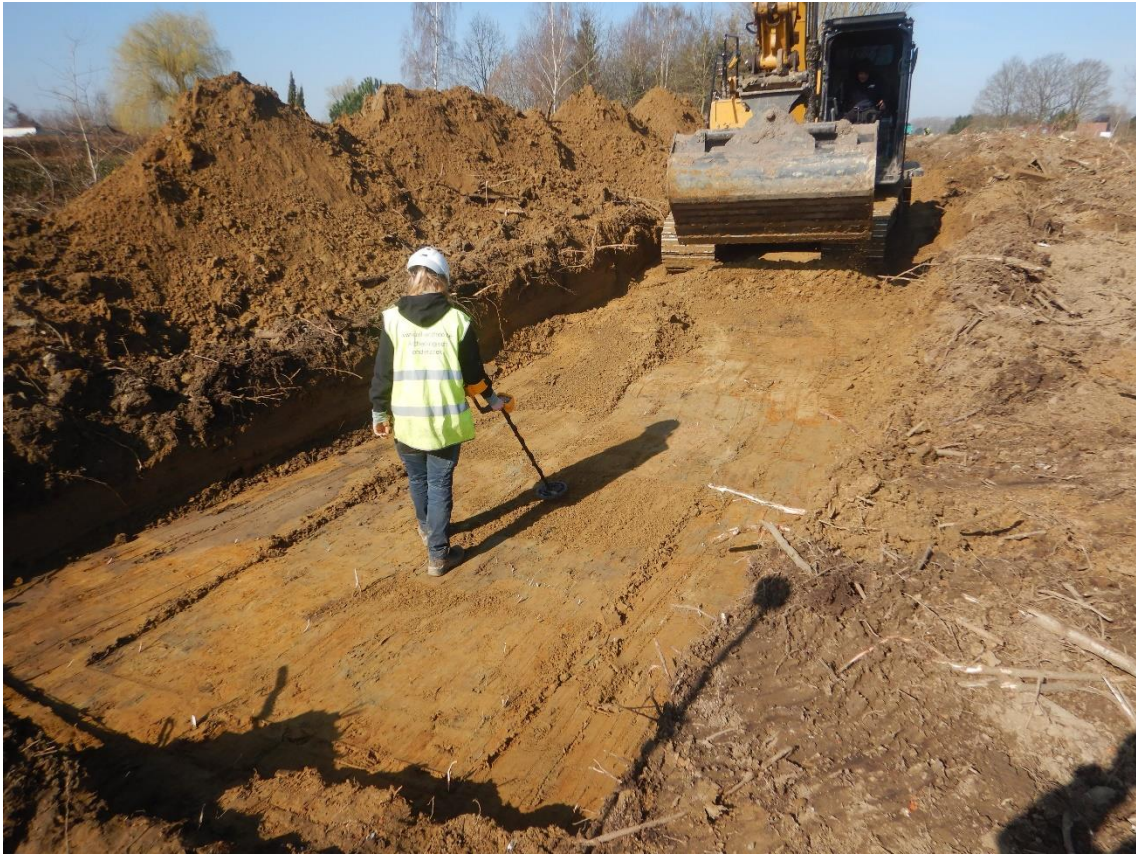
Figuur 9: Metaaldetectie tijdens het verdiepen van het niveau ter hoogte van de vermoedelijke crash site van Britse Hawker Hurricane
