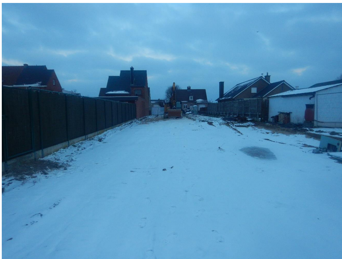
Figuur 6: Zicht op de smalle doorgang voor aanvang van het onderzoek, waar sleuf 6 is getrokken.
