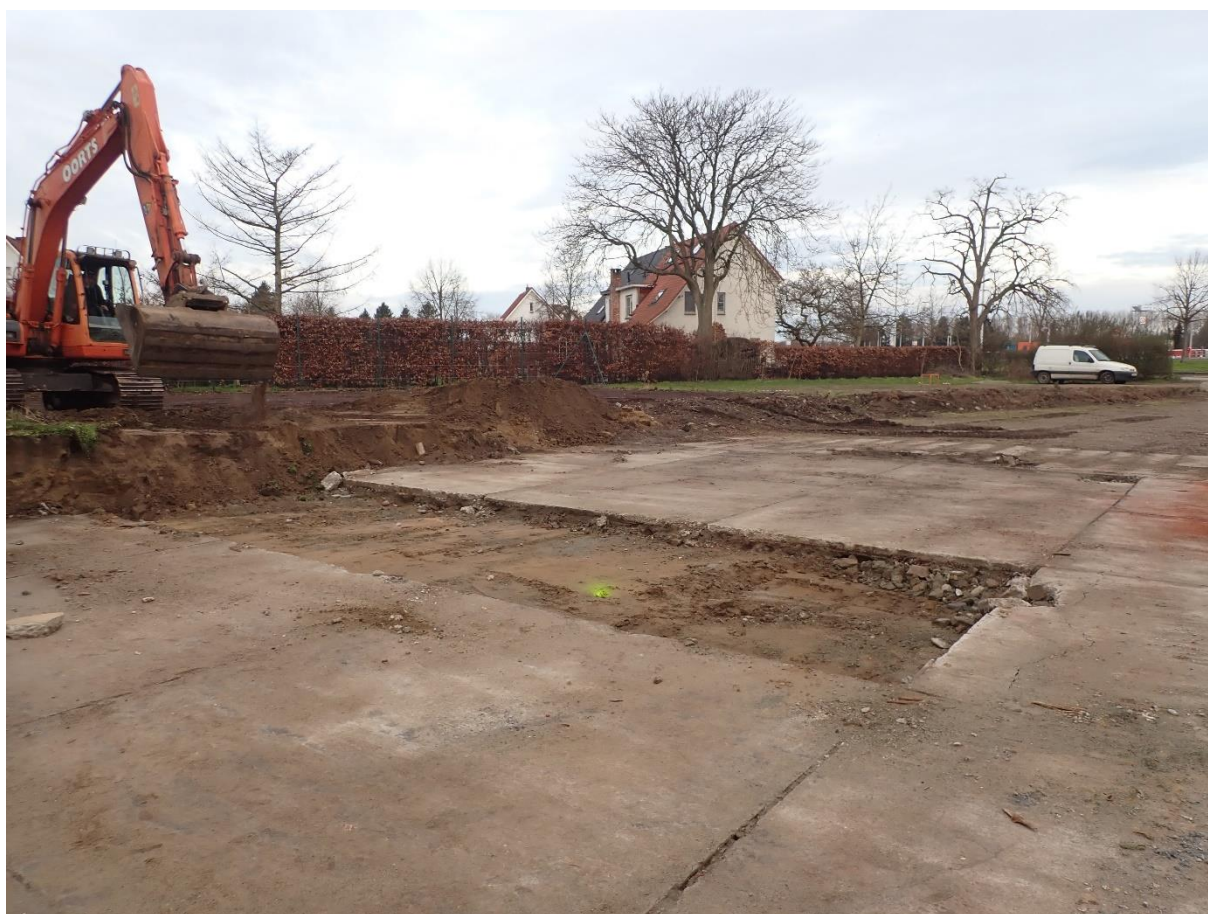
Figuur 2: Zicht op de plaatselijk verwijderde verharding ter hoogte van Werkput 1
