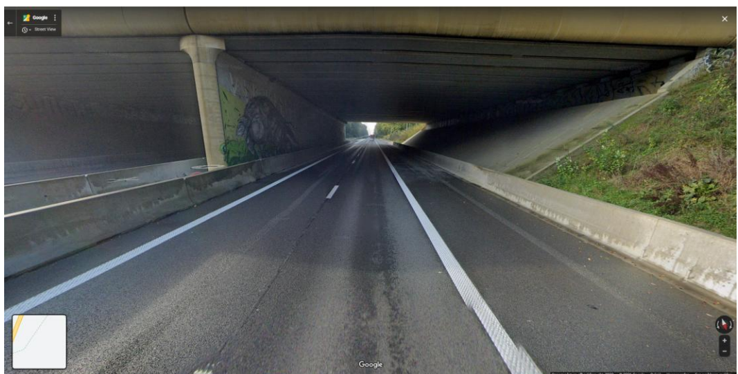
Afb. 9. Het zuidwestelijk deel van plangebied, ter hoogte van de het ecoduct. (Bron: Google Maps)
