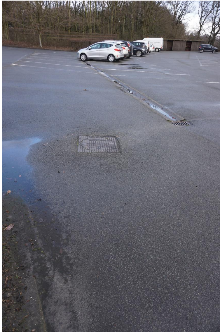
Fig. 2.7: Overzichtsfoto van het terrein in westelijke richting.
