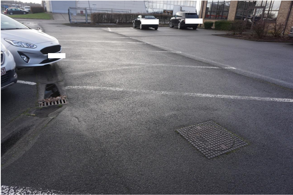
Fig. 2.6: Overzichtsfoto van de verharde parking, putdeksels en het af te breken kantoorgebouw in oostelijke richting.
