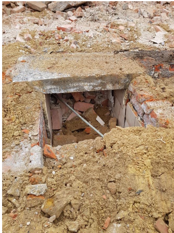
Figuur 2. Onderzoeksgebied tijdens het proefsleuvenonderzoek: kelder aan straatkant.
