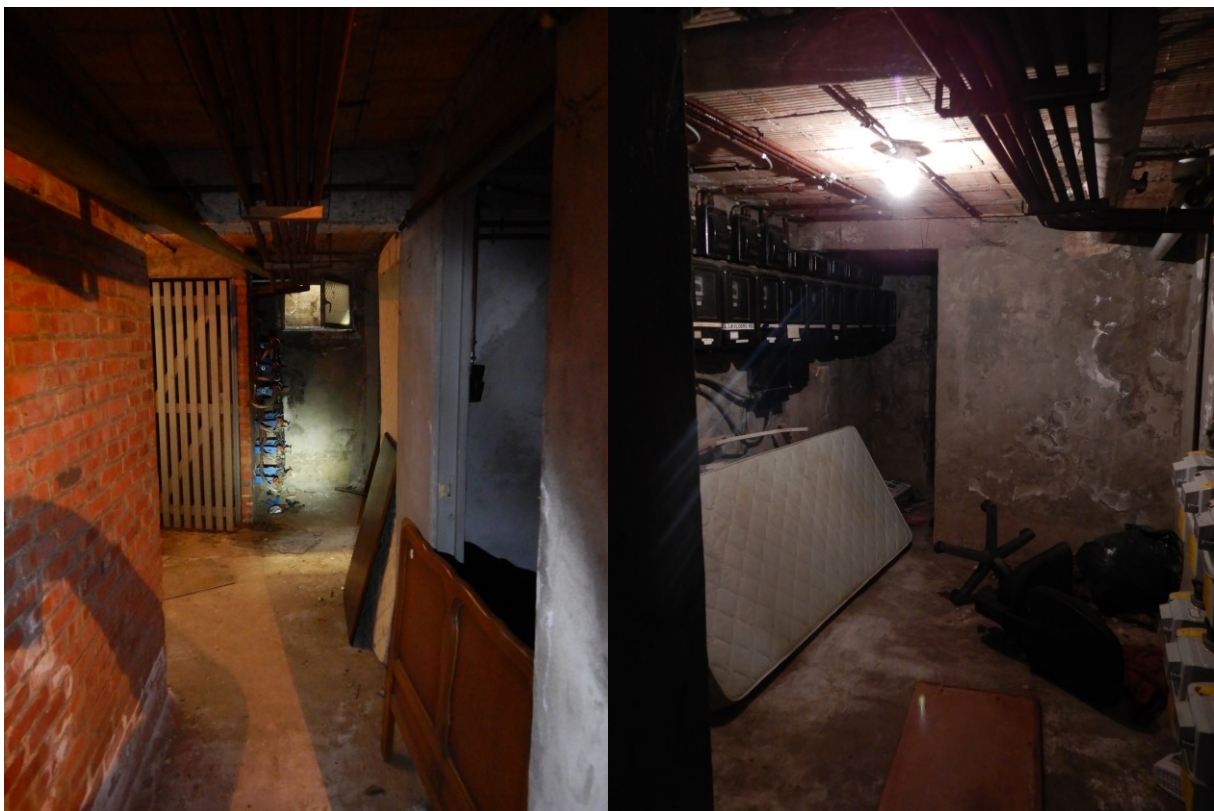
Fig. 1. Foto's van de kelders onder de voormalige gebouwen in het noordoostelijke deel van het projectgebied.
