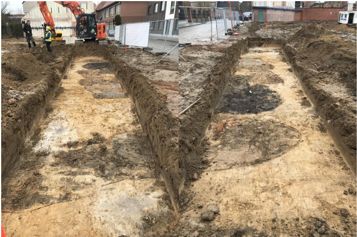
Fig. 4. Overzicht van werkput 3.
