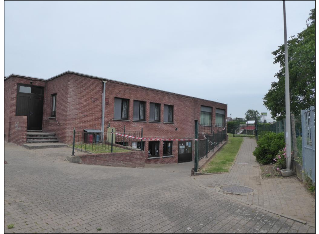
Foto 8: Zicht op het parochiaal centrum met verdiepte toegang naar de kelder en zuidelijk verhard pad met riolering. Foto genomen vanuit het zuidwesten.
