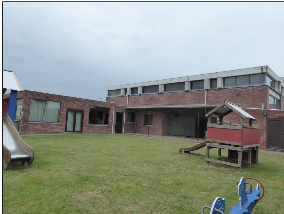
Foto 14: Zicht op de speelzone met achteraan de af te breken veranda en het afdak en helemaal rechts de berggruimtes. Foto genomen vanuit het oosten.
